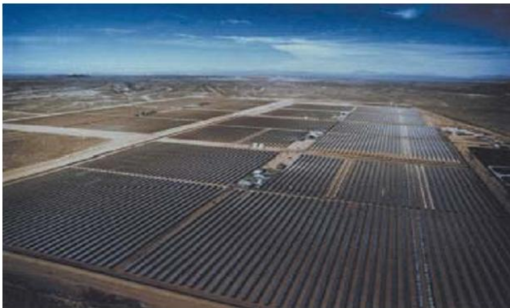
Figure 1. 2: Vue aérienne de 5 centrales SEGS [2]
