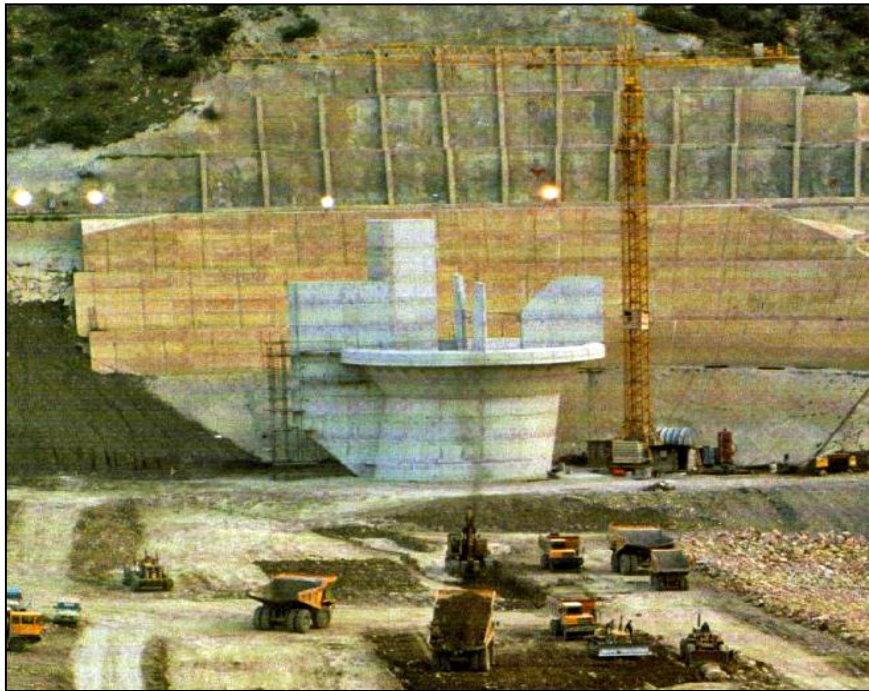
Figure 1.8. Travaux génie civil du Barrage Hammam Debagh ; Source : ANB (1985)
