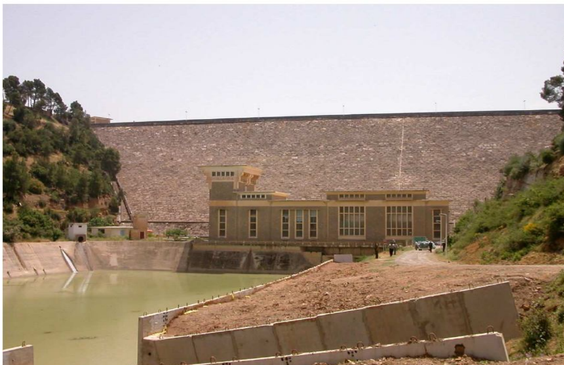
Figure. IV.34. vue générale du barrage de Ghrib
