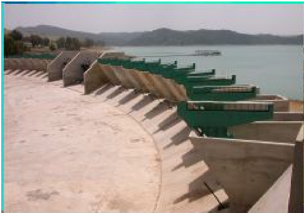
Figure.IV.36. la surélévation du barrage du Ghrib (source ANBT 2008)
