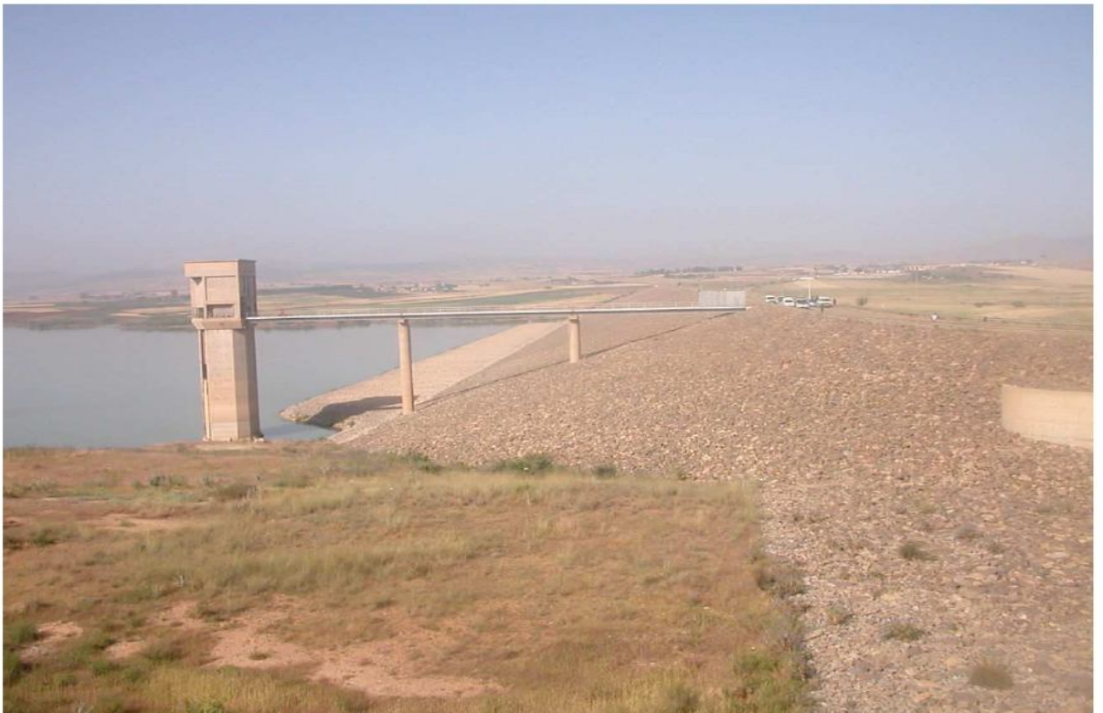
figure .IV.39.vue générale de la digue du barrage de Harreza
