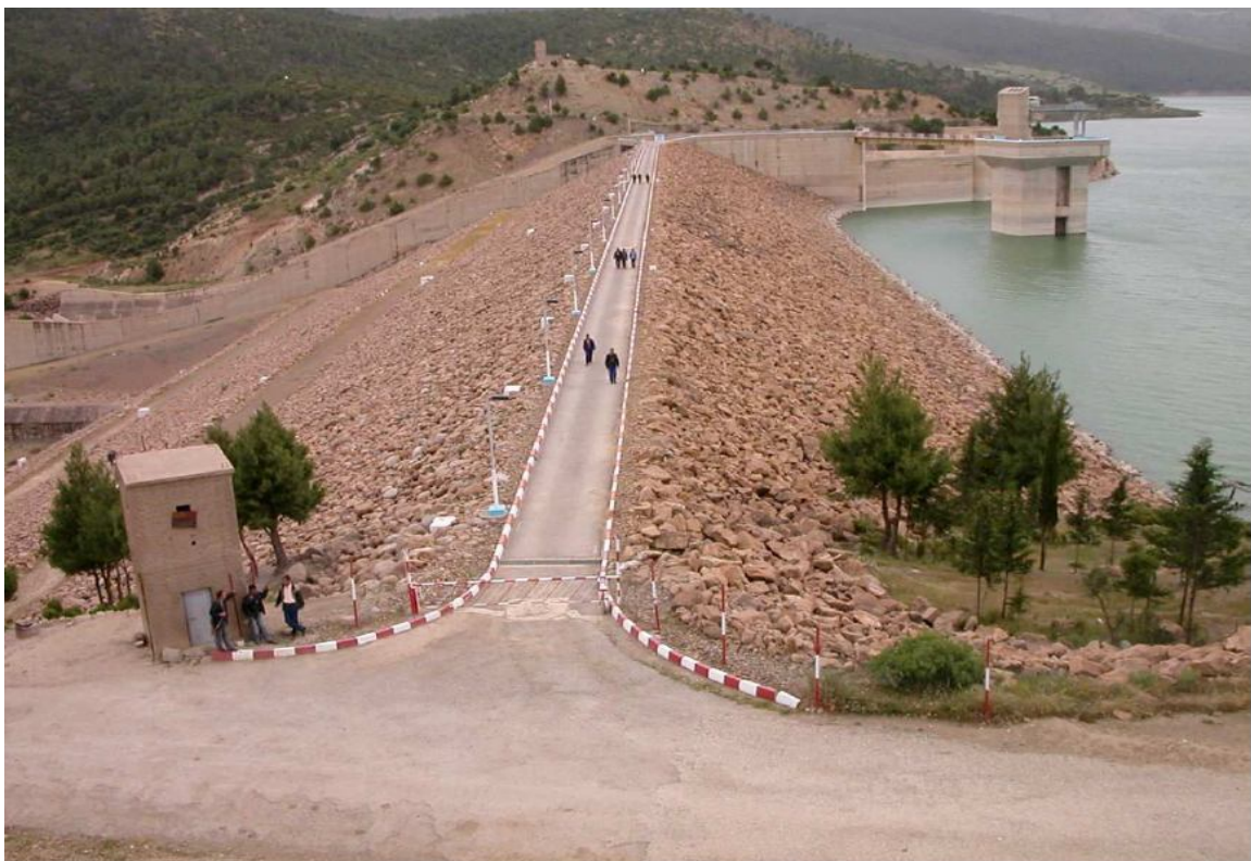
figure .IV.37. une vue général du barrage de Deurdeur
