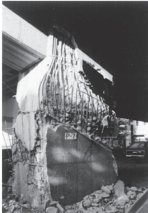
Figure 1.18 : Échec de fût avec éclatement des armatures longitudinales voisine à mi-hauteur durant le séisme de kobé 1995 à Hyogo-Ken Nanbu [1].
