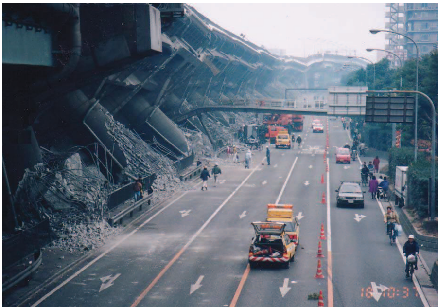
Figure 1.3 : l'Échec du viaduc de Higashi-Nada Durant le seisme de Hyogo-Ken Nanbu de kobe 1995 [10]
