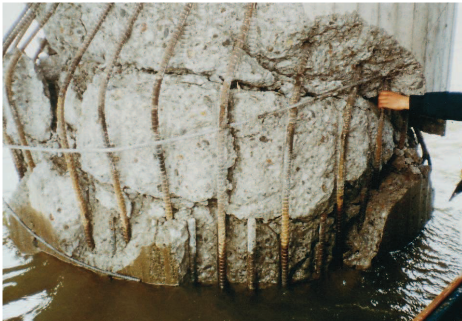
Figure 1.18 : Échec de fût avec éclatement des armatures longitudinales voisine à mi-hauteur durant le séisme de kobé 1995 à Hyogo-Ken Nanbu [1].
