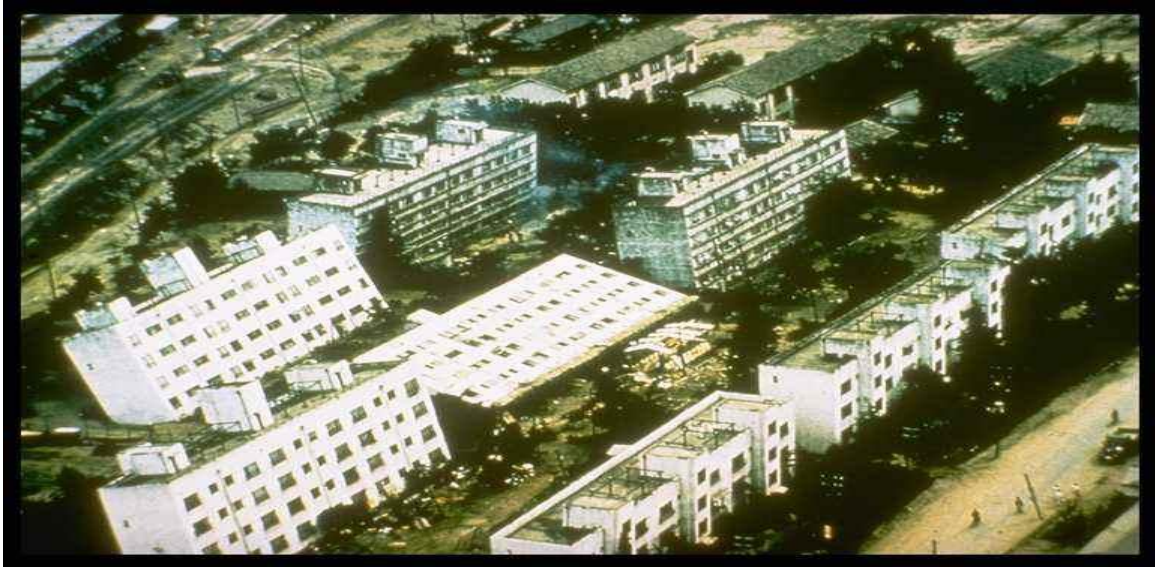
Figure 1.2 : Enfoncement, basculement et renversement des bâtiments lors du séisme de Niigata Japon (1964)
