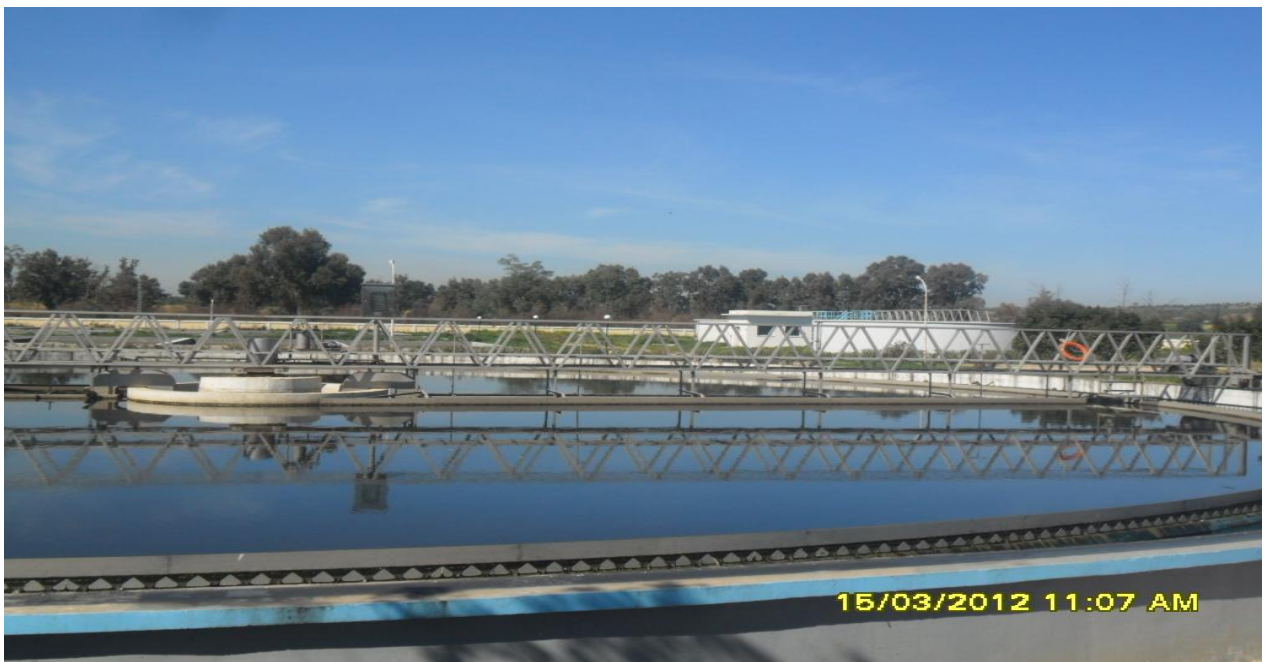
Figure I.4 : Décanteur.
