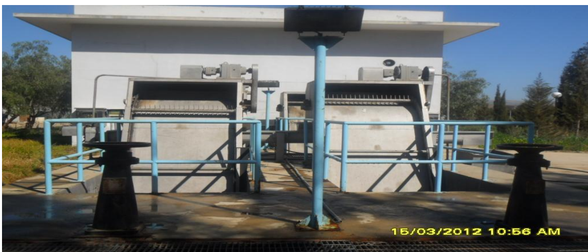
Figure I.1 : Dégrilleurs
