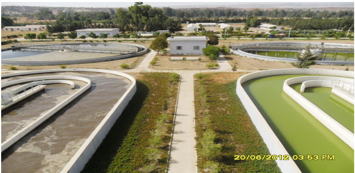
Figure I.3: Bassin d'aération.
