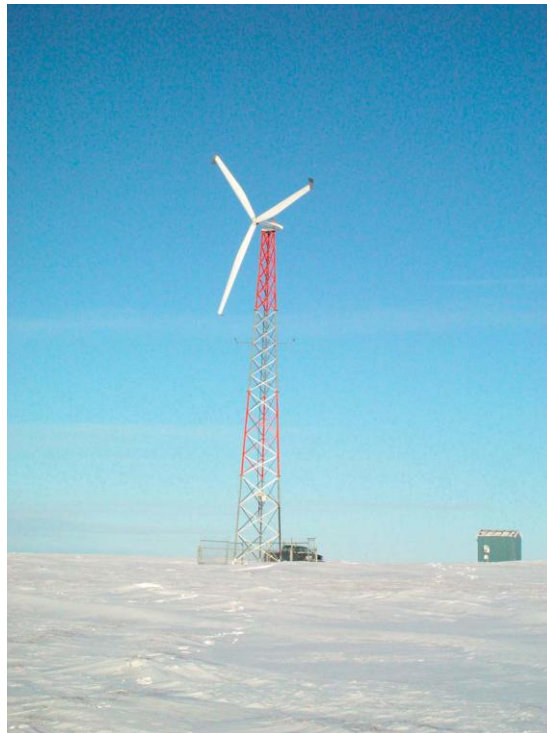
Figure 2.11 : Éolienne de 50 kW reliée à un réseau isolé au Canada.
