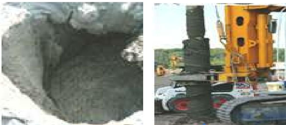
**Fig. 1.5-** Mise en œuvre colonnes à module contrôlé.
