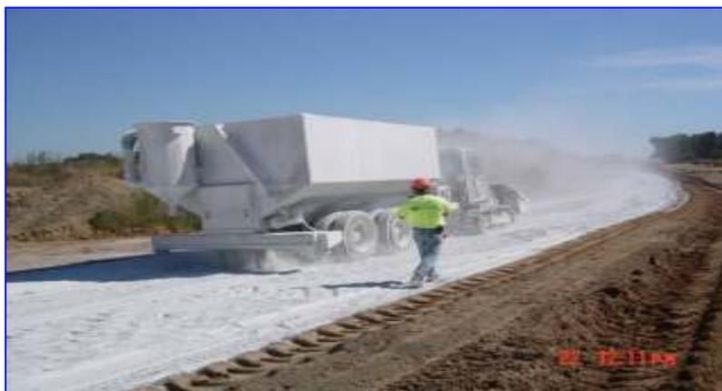
**Fig. 1.10-** Stabilisation chimique.
