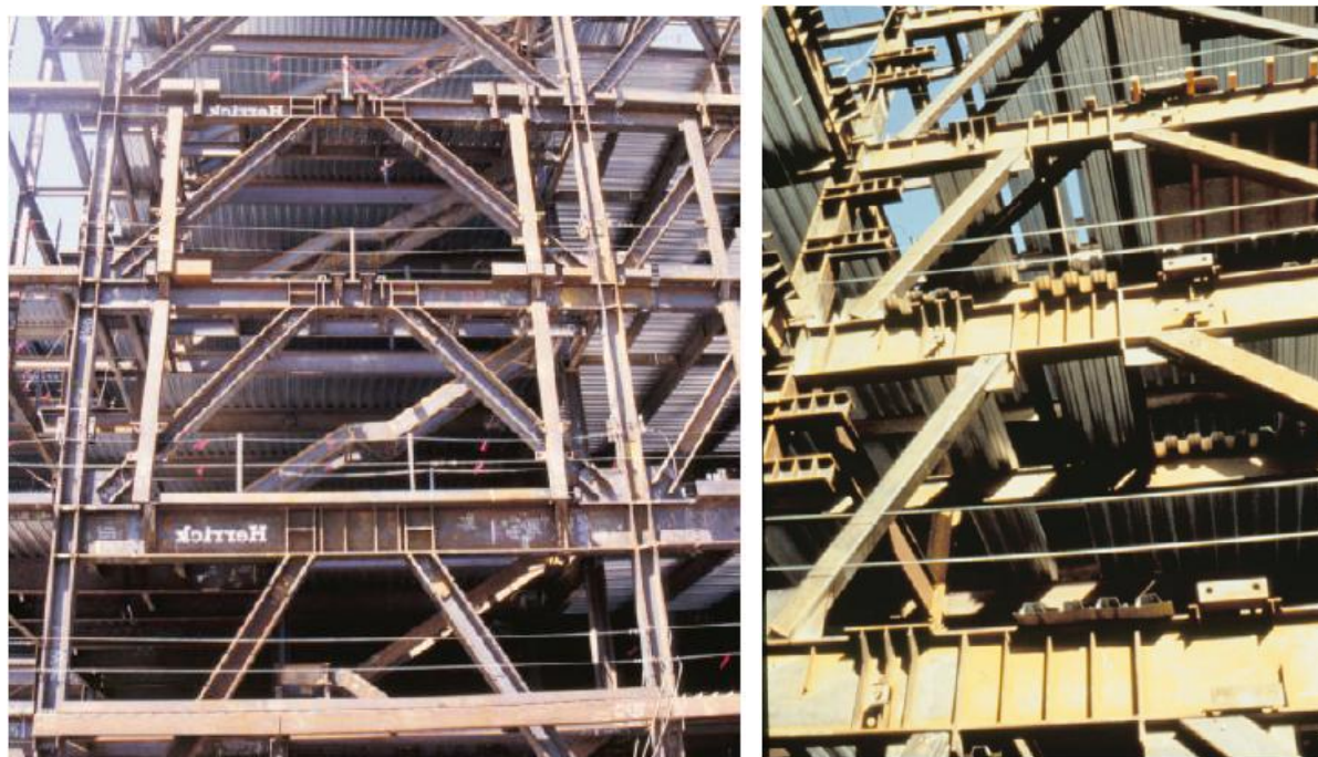
Figure 2.13 Raidissage du tronçon d'excentrement court en cours de construction
