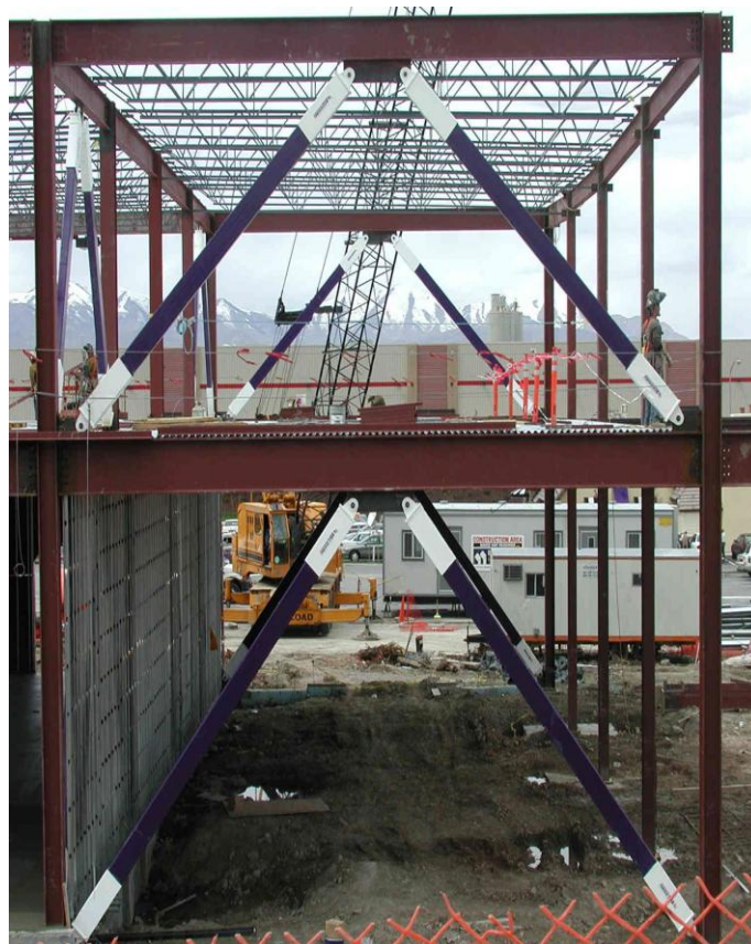
Figure 3.18 Structure avec barre résistante au flambement en cours de construction (Etats Unis)
