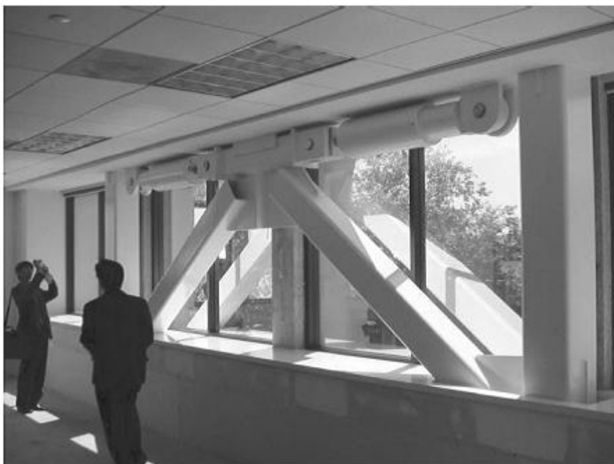
Figure 3.22 dispositif d'amortissement visqueux dans un bâtiment.
