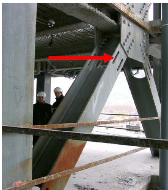
Figure 2.8. Affaiblissement à l'extrémité de chaque barre de contreventement, « zone dissipative » de PS-92
