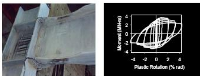
Figure 3.13 Comportement excellent d'une poutre à section réduite
