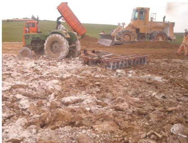
Photo N°10 : Malaxage du sol avec la chaux
