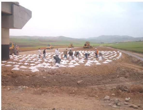
Photo N°9 : Epannage de la chaux sur le sol à traiter
