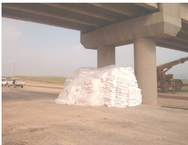
Photo N°12 : Stockage de la chaux
