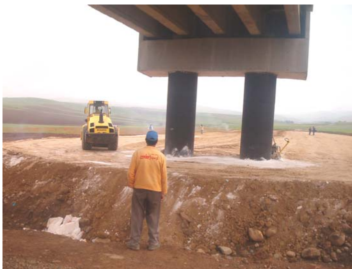
Photo N°11 : Compactage du sol traité
