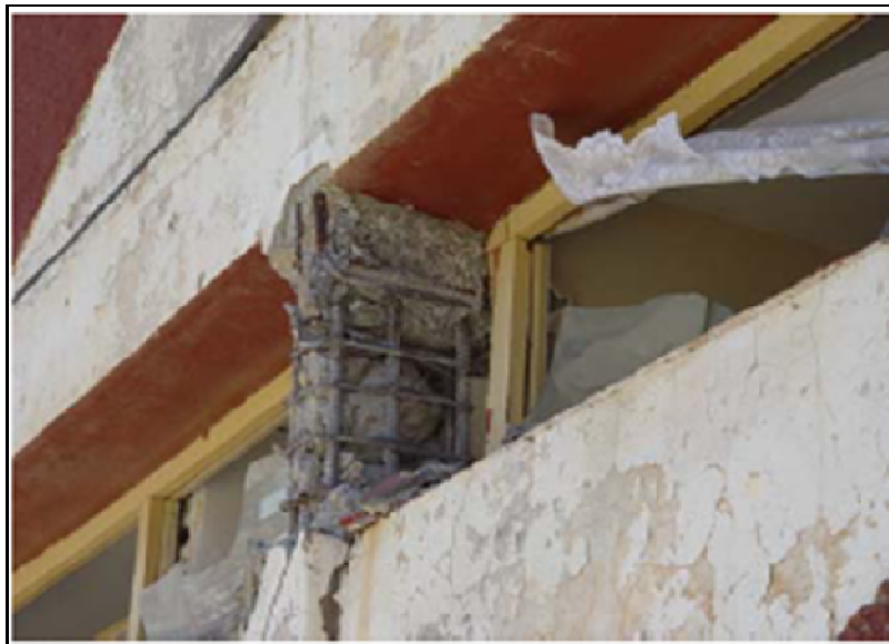
(b)- Destruction par cisaillement du poteau court
