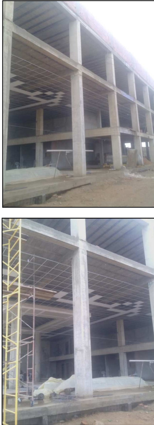
Figure 2.1 : Exemple de poteaux élancés dans une structure (Bâtiment situé au sud Hay Chorfa – Chlef)
