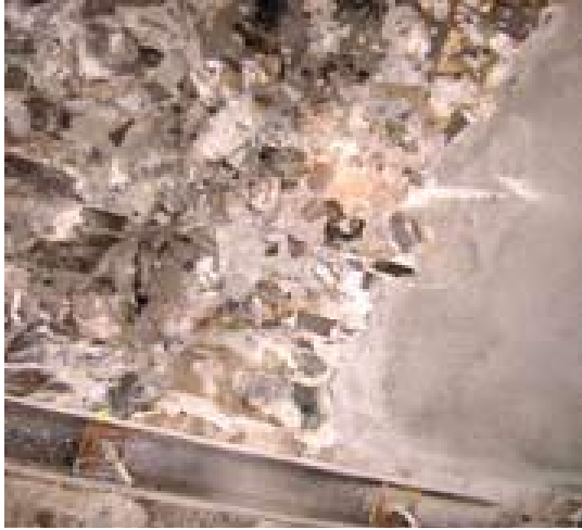
Réparation et réhabilitation
