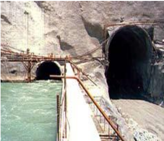
Galerie à eau
