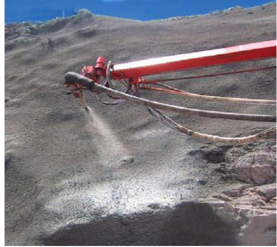
Stabilisation de talus
