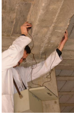
Fig. 3.18- Mesure du temps de transit sur une poutre.
