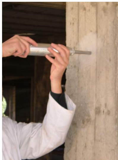
Fig. 3.19- Mesure de l'indice de rebondissement sur un poteau.
