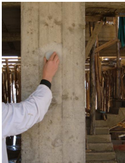
Fig. 3.17- Ponçage des surfaces à examiner sur un poteau.
