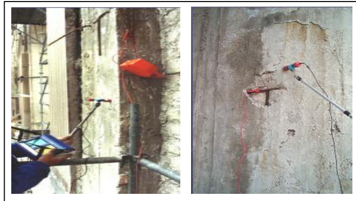
Fig. 2.3- Application de la technique de mesure de la résistivité du béton in situ.
