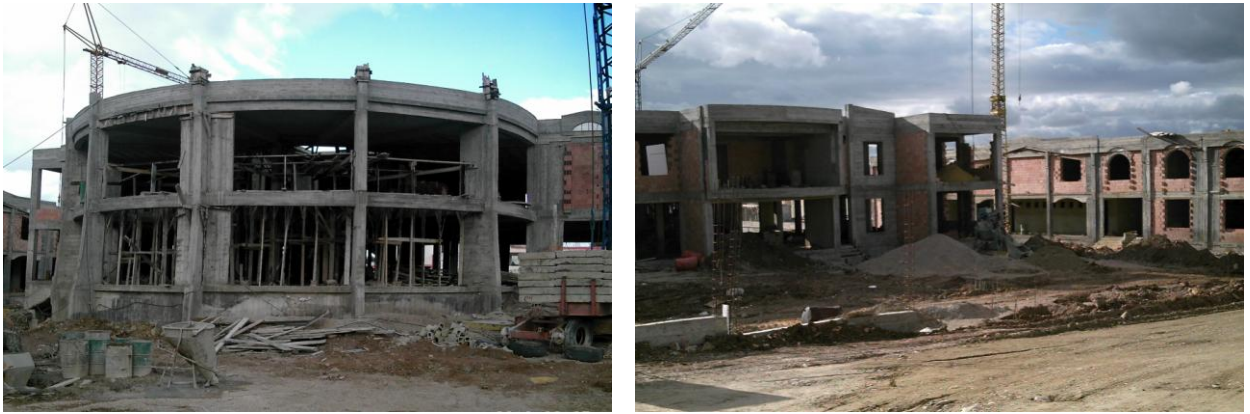
Fig. 3.10- Vues d'ensemble de la superstructure du projet n°1.
