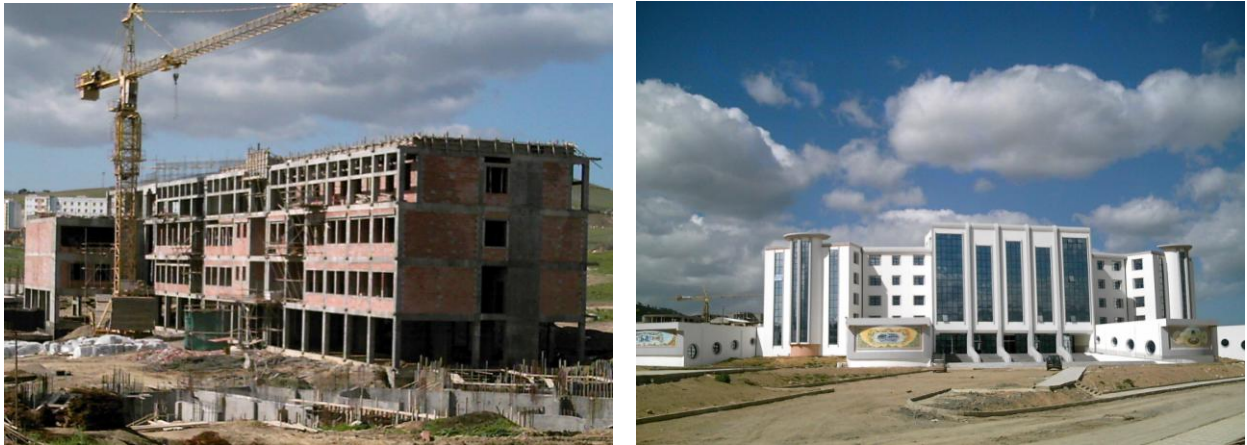
Fig. 3.12- Vues d'ensemble de la superstructure du projet n°2.
