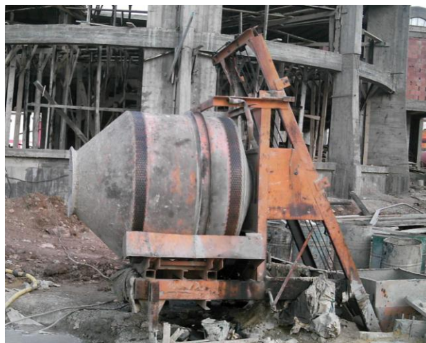
Fig. 3.11- Bétonnière pour malaxage du béton.
