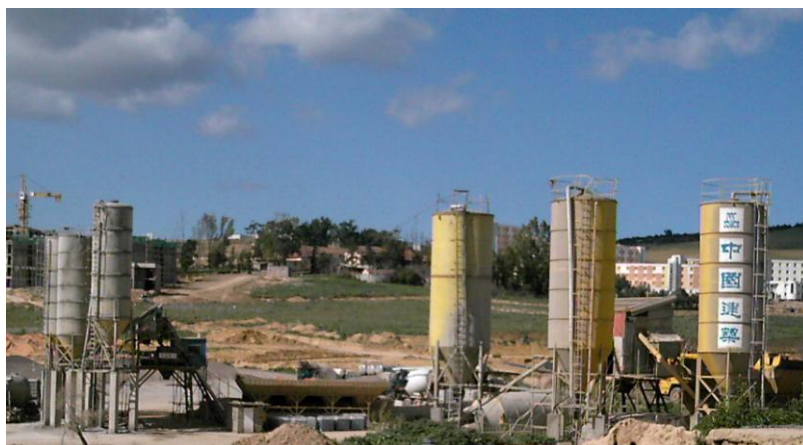
Fig. 3.13- Centrale à béton du projet n°2.
