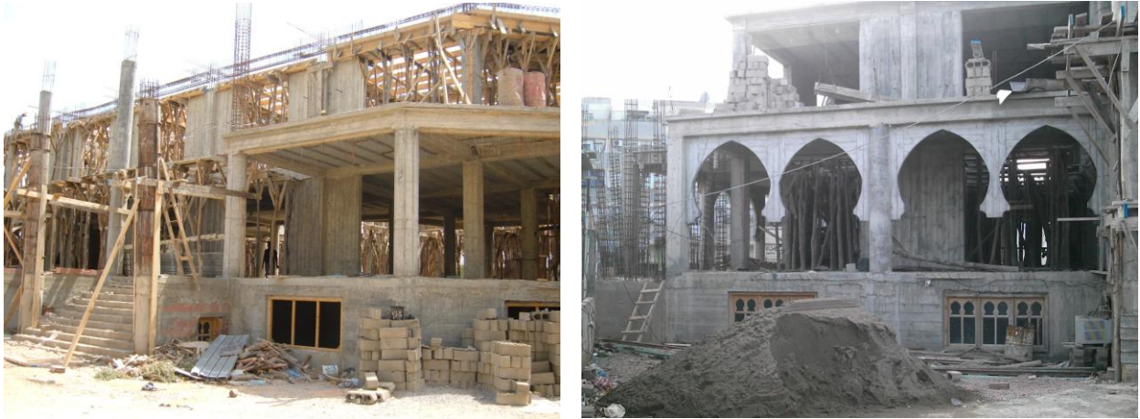
Fig. 3.14- Vues d'ensemble de la superstructure du projet n°3.
