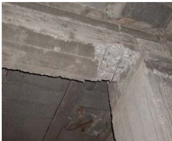
Figure 1.22 : Rotule dans la poutre (Comportement recherché) [13].
