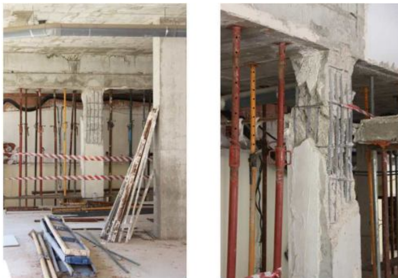
Figure 1.17 : Endommagement de poteaux s'adaptant aux différences d'hauteurs entre planchers [9].
