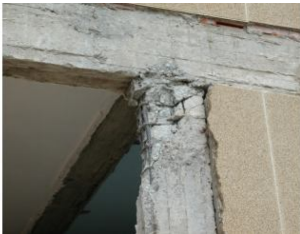
Figure 1.21 : Rotule dans le poteau (Comportement à éviter) [13].
