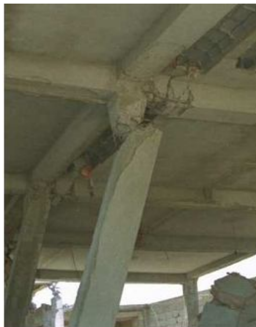
Figure 1.7 : Eclatement des armatures transversales [8].
