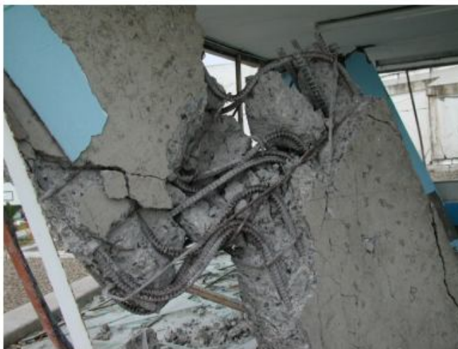
Figure 1.15 : Détail de cisaillement d'un des 6 poteaux [13].
