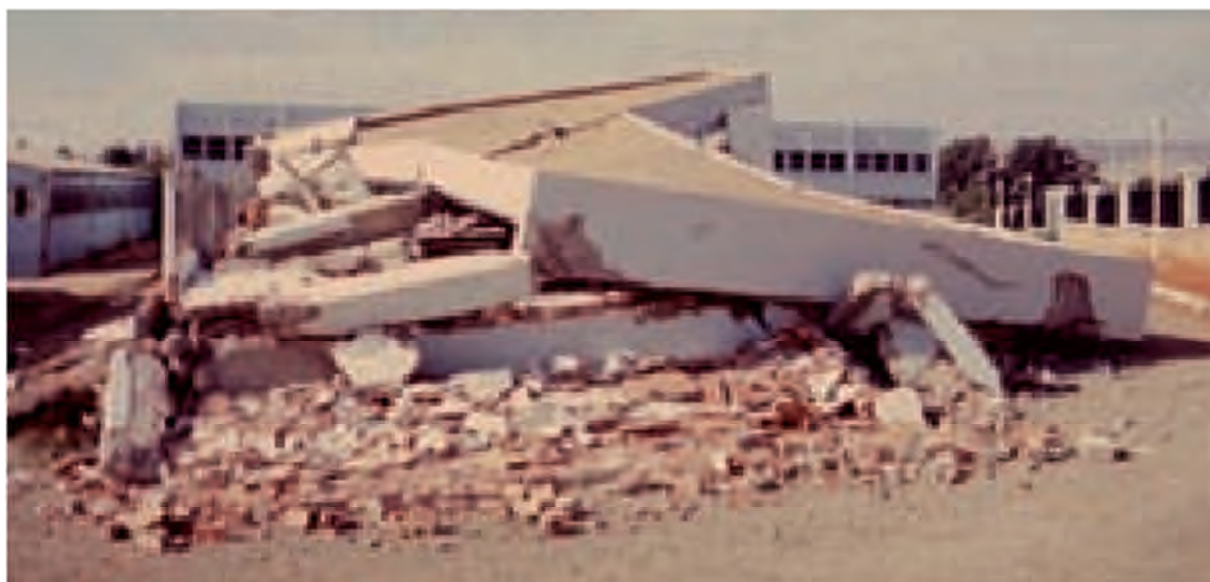
Figure.2.13: Effondrement dû à la torsion, El Asnam 1980
