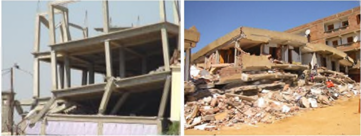
Figure I.2 : Effondrement de structures dues à des déplacements importants.
