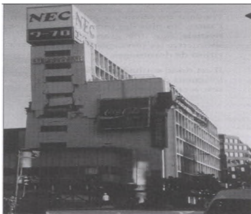
Fig.II.13.Dommages due à la présence de niveaux en retrait. Les désordres sont particulièrement localisés dans l'angle rentrant de la zone du retrait où se sont concentré les contraintes. (Séisme de Kobé, Japon, 17 janvier 1995)
