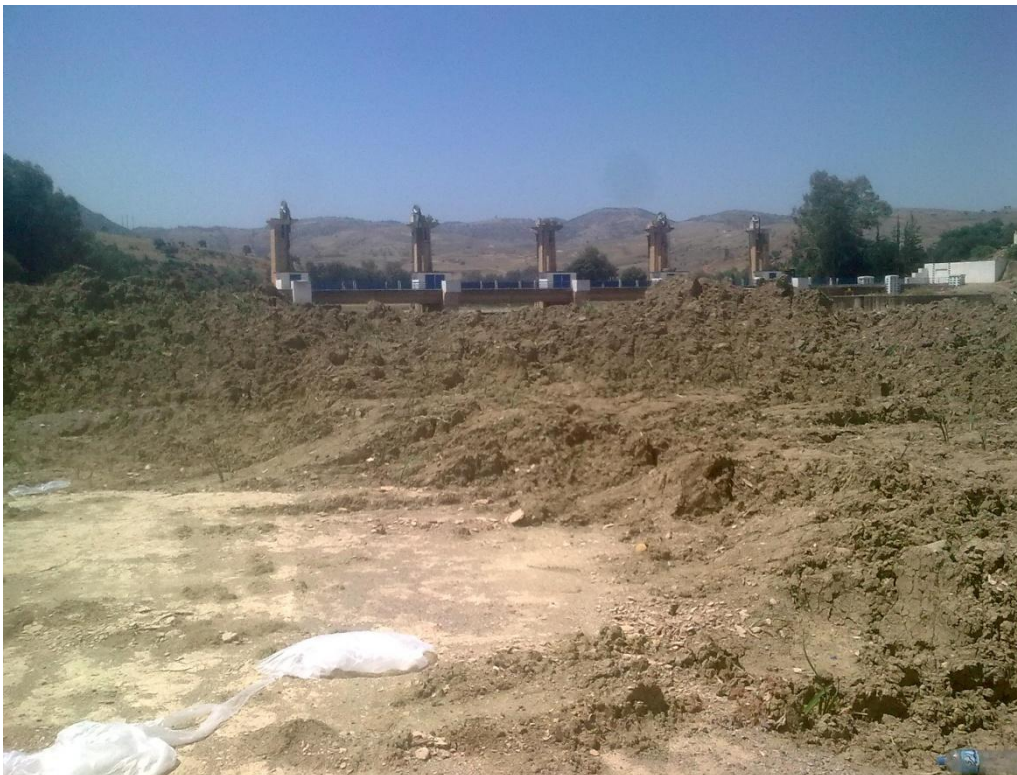
Fig. 4.1 – Dépôt de la vase draguée.
