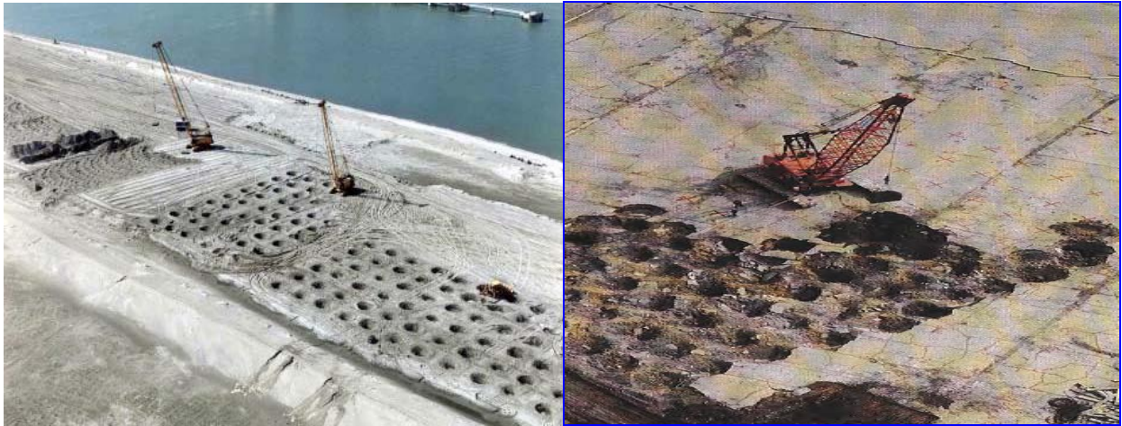
Fig. 2.2- Chantier d'un compactage dynamique profond [Lawton, 2004].
