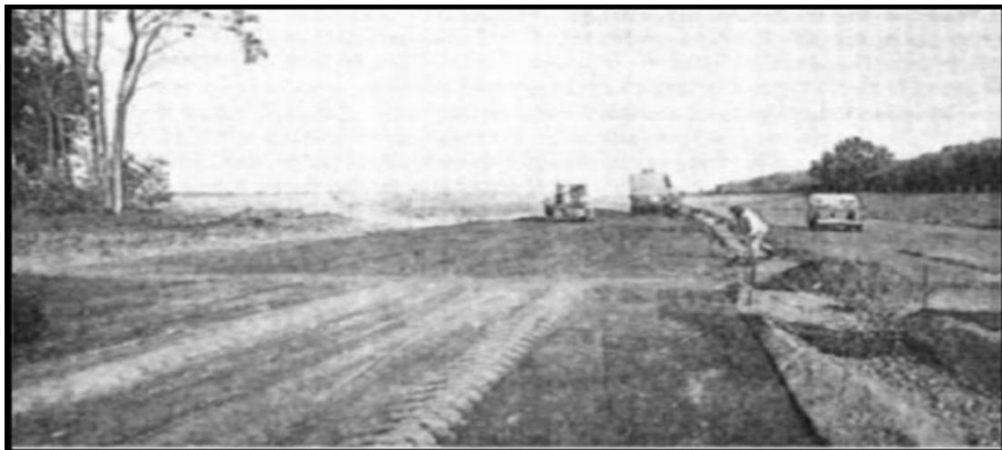
Fig. 2.10- Chantier de traitement du sol au ciment [Bell,1978].
