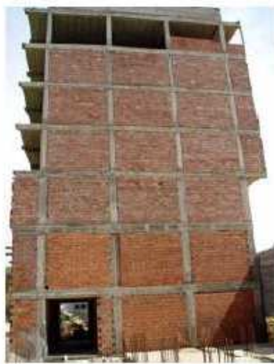
Figure 1.1 : Ossature contreventée par portique auto stable [2]
