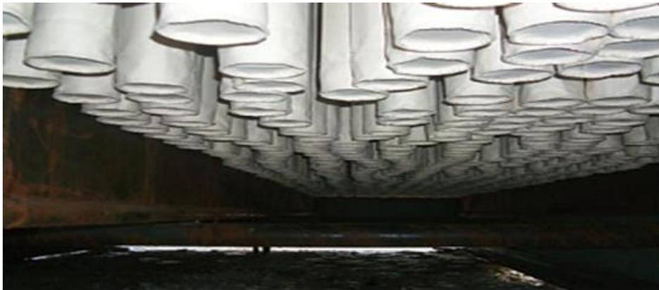
Figure 3.7 : Filtre constitué de grandes chaussettes
