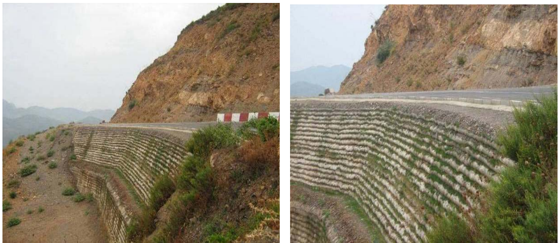
Figure 1. 24: Vue de l'ouvrage achevé (Arab.R,et al 2009)
