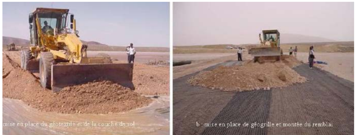
Figure 1. 18: Mise en place du géotextile et de la géogrille (Arab.R,et al 2009)
