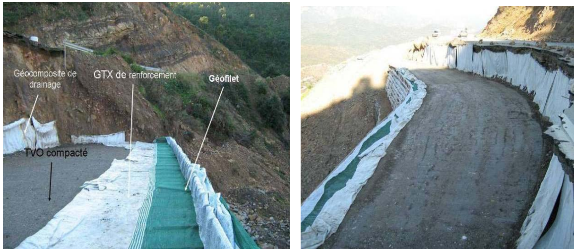
Figure 1. 23: vue de l'ouvrage pendant la phase travaux (Arab.R,et al 2009)
