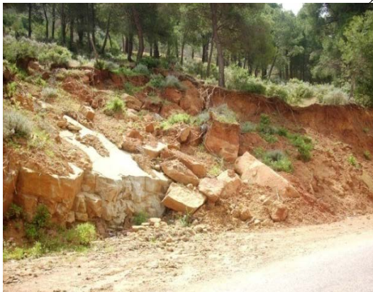
(a) Plans (BEDR, MAI 2007, RN 11 TÉNÈS, ALGÉRIE) (b) Glissement plan (Durville J. Sève G., 1996).
