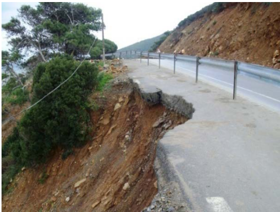
(a) Rotationnel (BADRE, JANVIER 2008 RN 11, DAMOUS, ALGÉRIE), (b) Glissement rotationnel (Durville J.L., Sève G., 1996).
