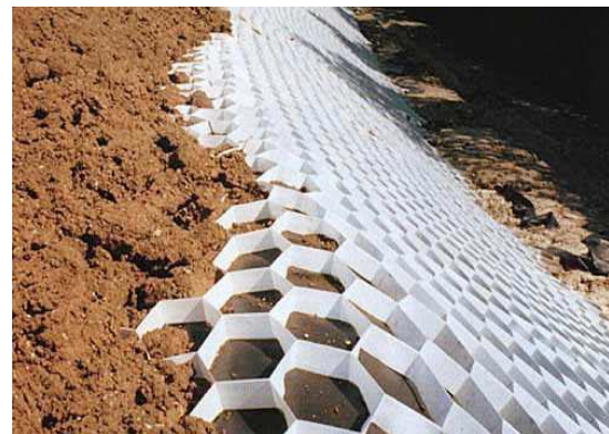
Figure 1. 14: Talus renforcé par des mattes.
