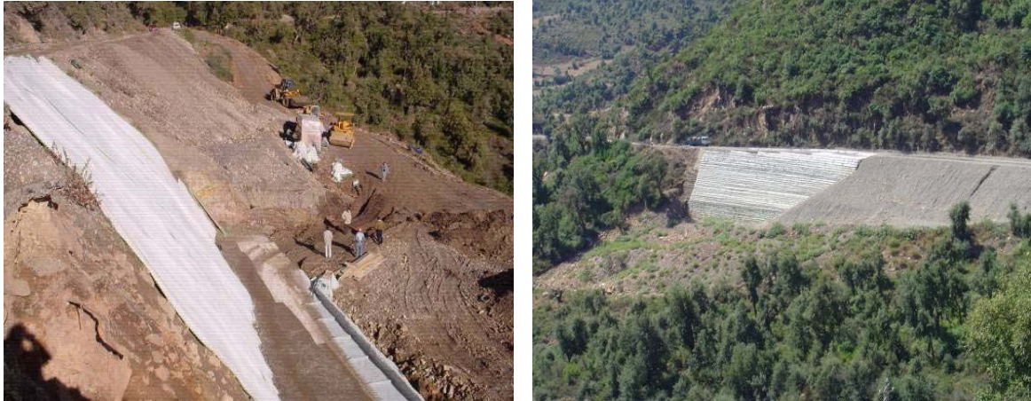
Figure 1. 21: Vues de l'ouvrage en cours de construction et achevé (Arab.R,et al 2009)
