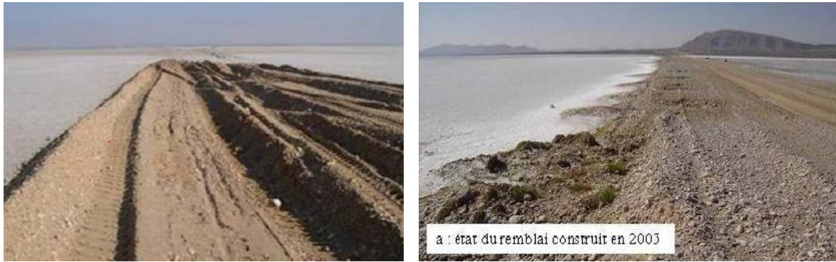
Figure 1. 17: Difficultés de mise en place de la première couche sans géotextile (Arab.R,et al 2009)
