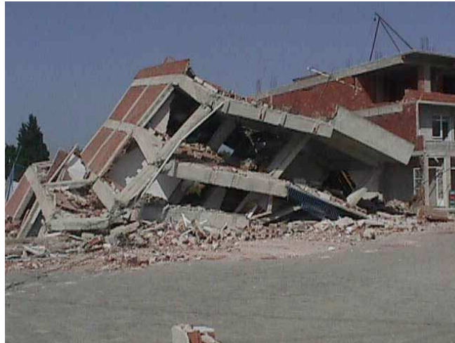
Photo 1.12: Effondrement par flexion hors plan d'une structure portiques béton armé lors du séisme de Izmir (Turquie) en 2002 [13]
