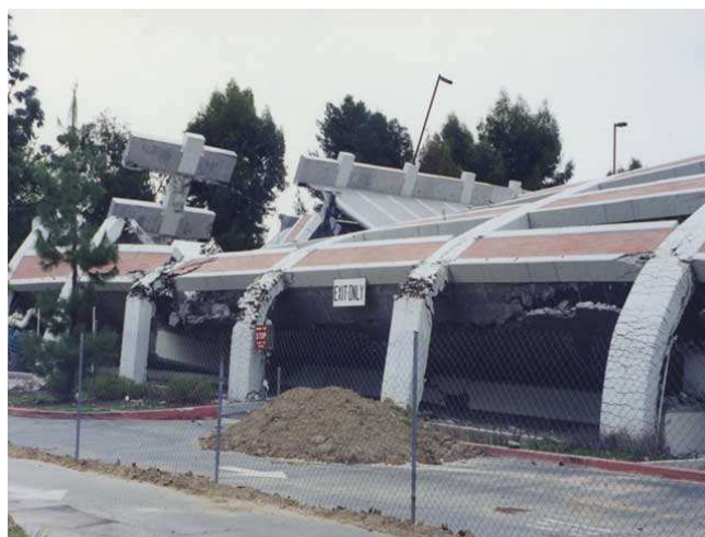
Photo 1.11: Effondrement par flexion hors plan d'une structure portiques béton armé (parking) lors du séisme de Northridge (Etats-Unis) en 1994 [11]
