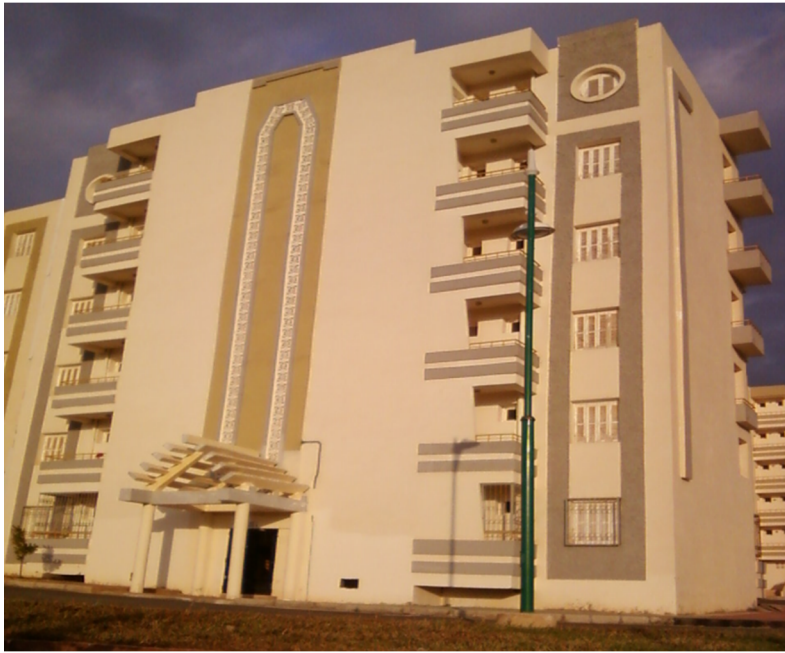
a) Vue réelle de la structure (existante)
