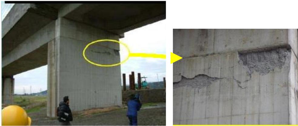
**Photo 8: Exemple D'éclatement De Béton Sur La Pile Du Pont "Higashi-Oh-Shin-E"**
