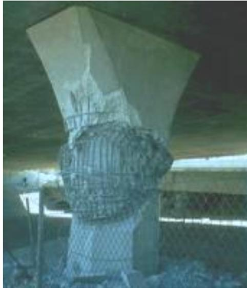
**Photo 6: Flambement Des Armatures Longitudinales + Eclatement Des Armatures Transversales De La Pile [58]**
