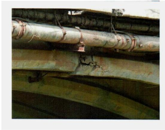
Eclatement de béton au niveau des poutres et dégradation importante (Pont sur oued *ALLALA*).
