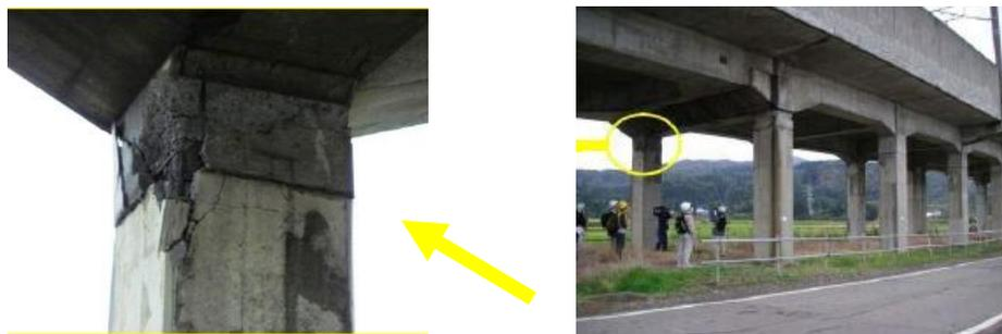
**Photo 9: Exemple D'éclatement De Béton Sur La Partie Supérieure Du Poteau (Pont Muramatsu)**
