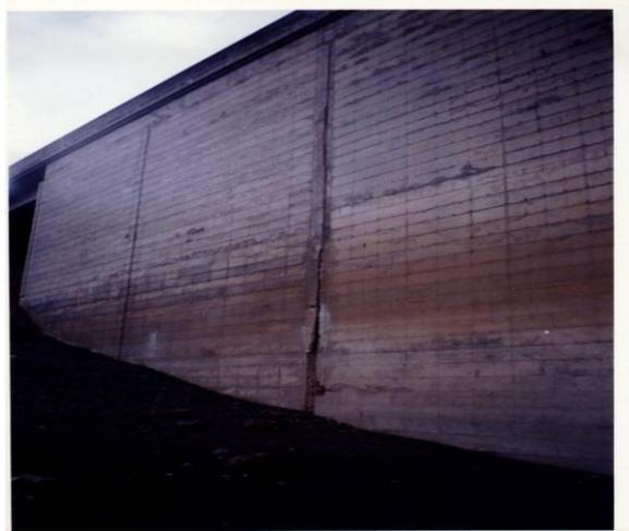
**Photo 3: Exemple De Martèlement (Pont Sur Oued El Bared, Kherrata, Bejaïa).**
