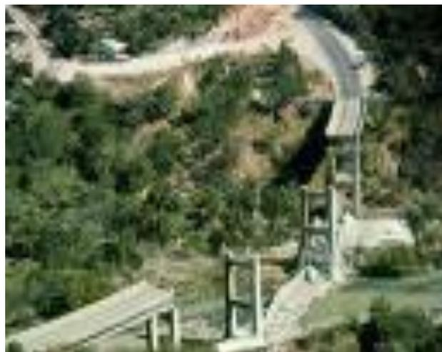
**Photo 2 : chute de travée due à un important angle biais [58]**
