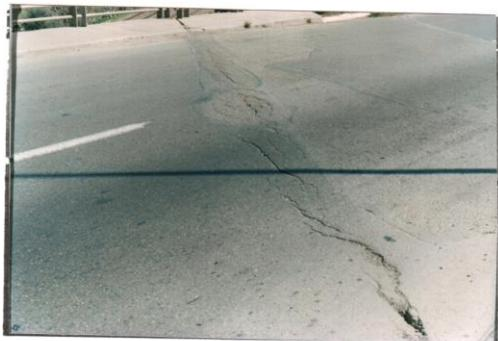
Fissure de la chaussée (pont sur voie ferrée RN4).
