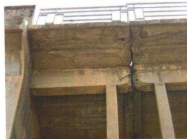
Fissures et éclatement de béton (Pont sur oued *CHLEF*).
