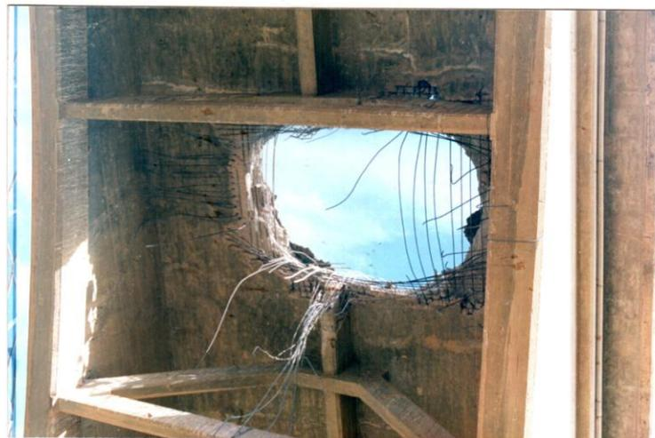
Cratère de 2m de diamètre au niveau du tablier provoqué par un acte de sabotage (Pont sur *CW73*).
