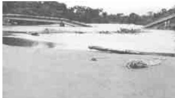
Photo 7 : Exemple de liquéfaction (Costa Rica, 1990)
