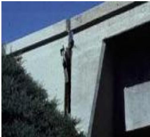
**Photo 4: Exemple De Martèlement Au Niveau De La Culée [58]**
