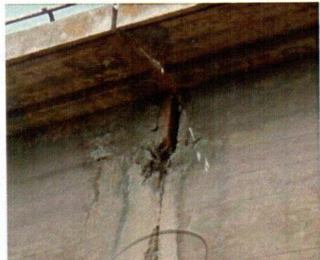
Fissure et défaut d'alignement au niveau du joint (Pont sur oued *CHLEF*).
