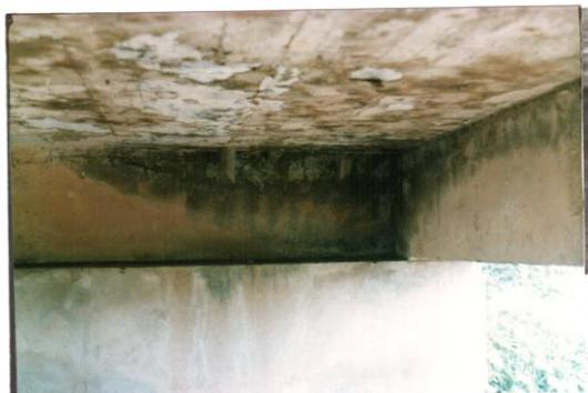
Traces d'infiltration d'eau. Carbonisation du Béton sur l'intrados du tablier.
