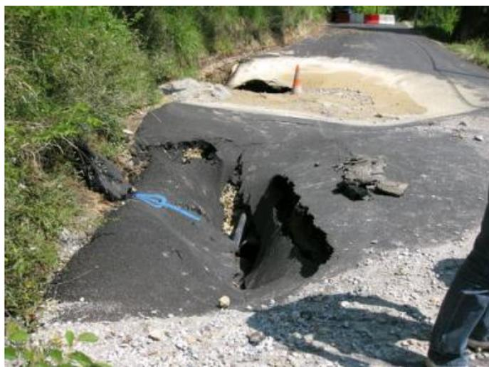
**Photo 14: Liquéfaction Du Sol Au Niveau De La Chaussée D'une Route.**
