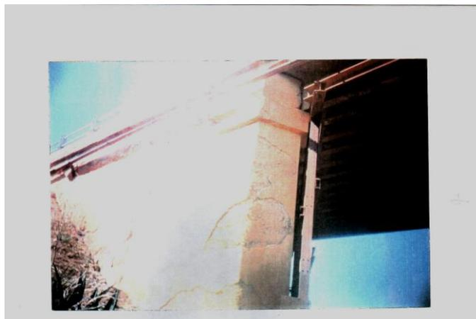
Fissuration apparente sur le mur en retour (passage supérieur ex RN4).
