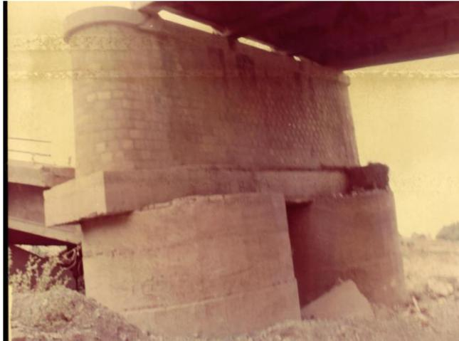
**Photo 17: Basculement De La Pile Entraînant La Chute Du Tablier.
