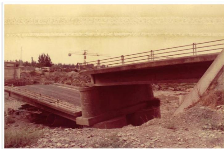
**Photo 16: Tassement De La Pile Entraînant La Chute Du Tablier.
