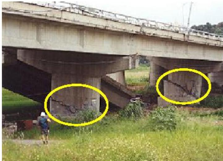
**Photo 5: Rupture Des Piles Du Pont Par Effort Tranchant
