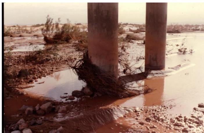
**Photo 13: Liquéfaction De Sol Au Niveau Du Lit D'oued
