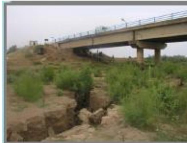
**Photo 15: Affaissement De Terrain Au Niveau du lit d'oued (Pont sur oued Isser)**
