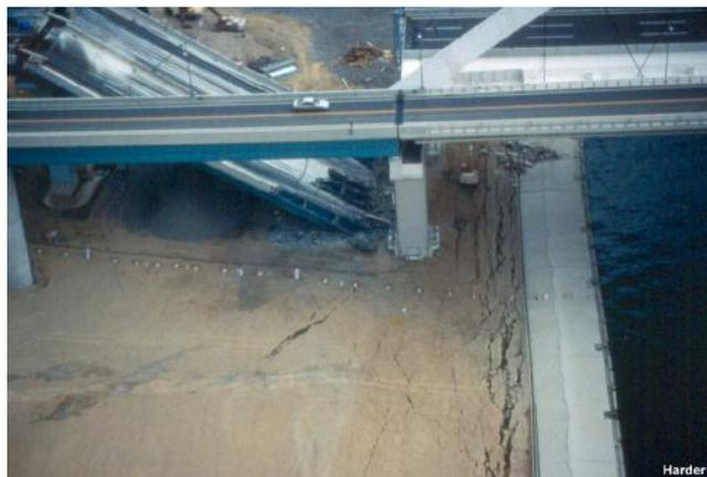
Photo 11: Effet De Liquéfaction, Pont De Nishinomiya (Séisme De Kobé 1995)
