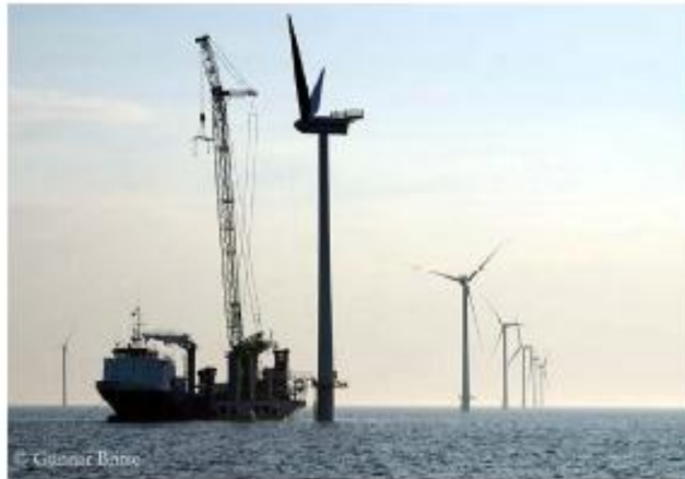
Figure I.1 : installation d'éoliennes offshore en Mer [BOY06].
