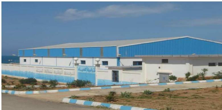
Figure IV.1 : Photo de la station de dessalement de Mainis.
