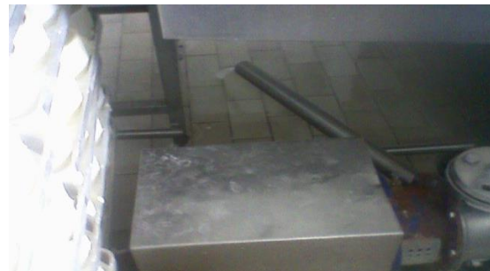
P2 : Point de rejet de l'eau de lavage
