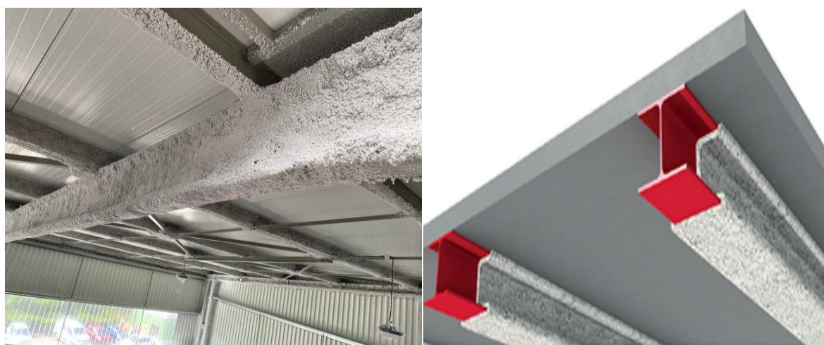
Figure 1-13 Figure Panneaux résistants au feu [16].
