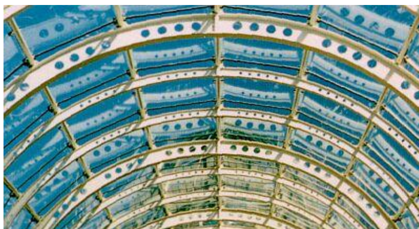
Figure 1-4 Poutre courbe à ouverture d'âme[5].
