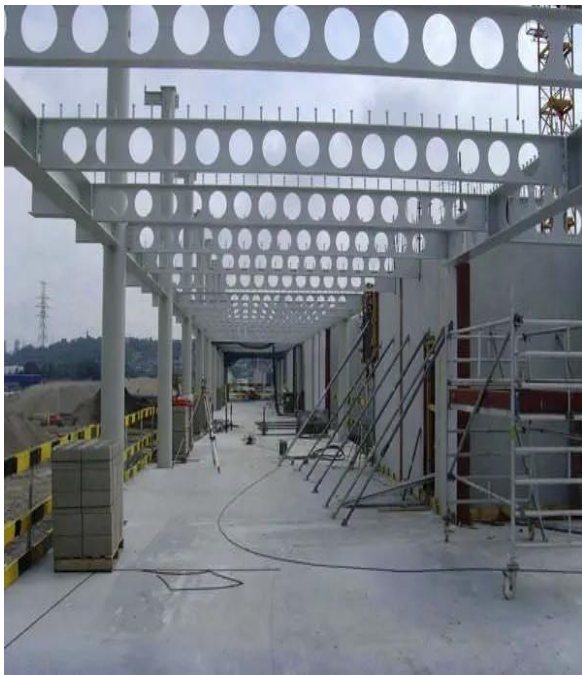
(a) Poutres métalliques cellulaires [4].
