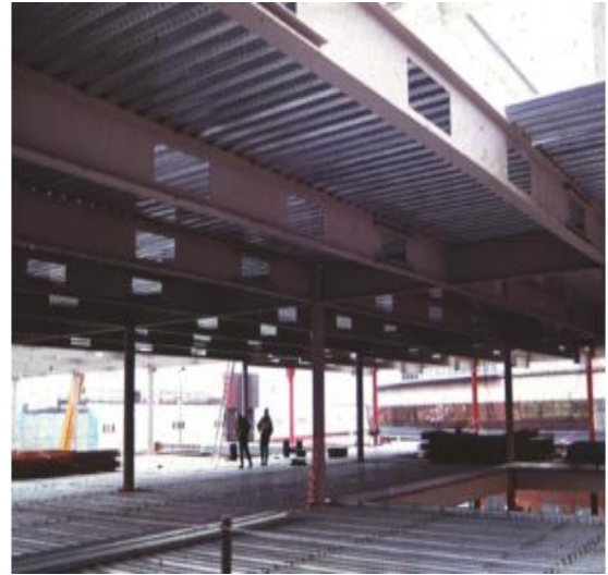
(d) Poutre à ouverture rectangulaire [5]
