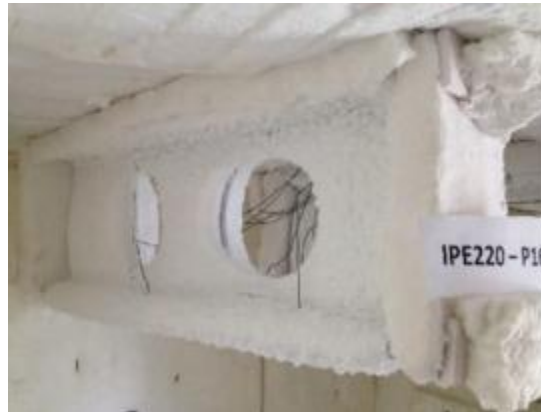
Figure 1-14 Expansion du revêtement intumescent après l'essai [17].
