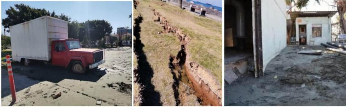
Figure.I.8 : Dégâts et déformations du sol à Iskenderun à cause de la liquéfaction- Iskenderun/ Hatay (séismes de 2023 à Kahramanmaras). (Toprak et al., 2025)
