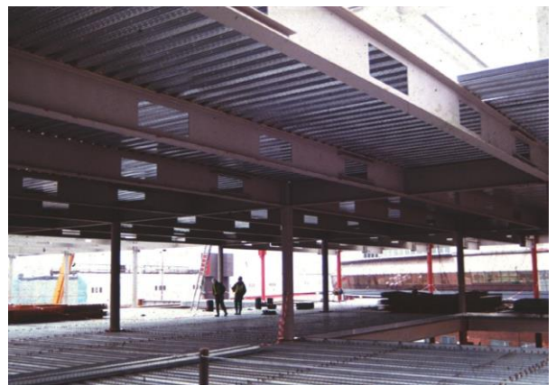
(f) Poutre à ouverture rectangulaire [5].
