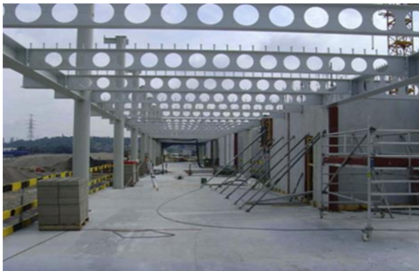
(c) Poutre à ouverture cellulaire [4].
