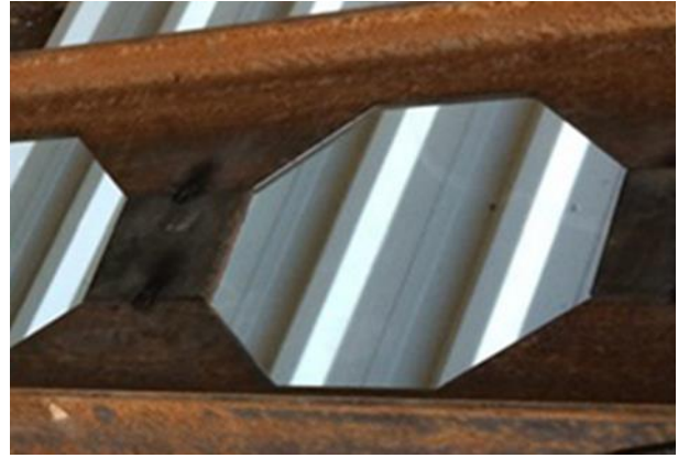
(b) Extension poutre à ouverture alvéolaire [5].
