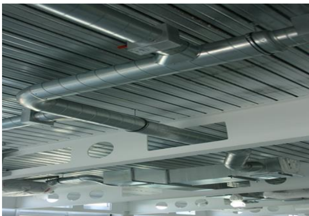
(e) Poutre à ouverture irrégulière [4].
