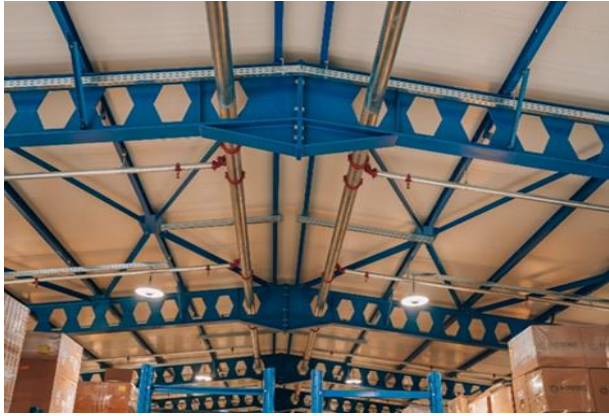
(a) Poutre à ouverture alvéolaire [4].
