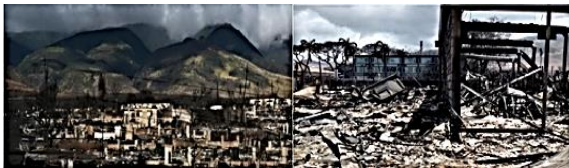
(a) Incendie périurbaine d'Hawaï, 2023[26]
