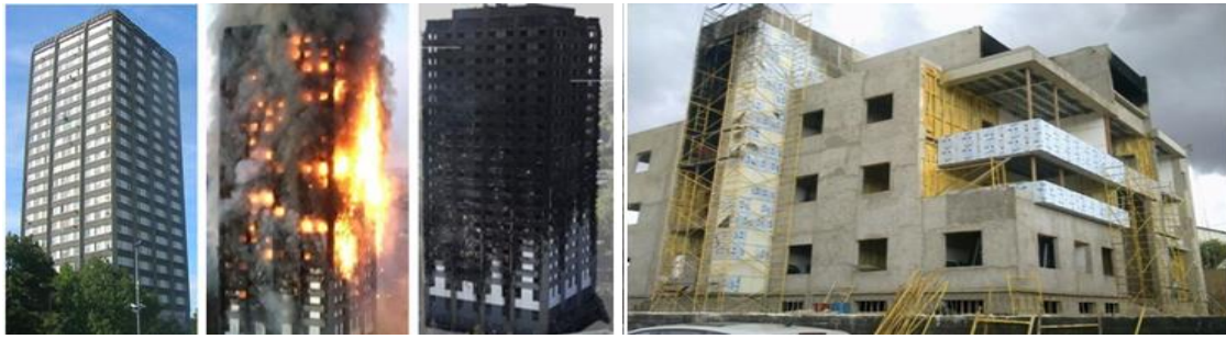
(a) l'incendie de la tour Grenfell à Londres en 2017[25] (b) l'incendie du bâtiment NAFTAL à Chlef [14]
