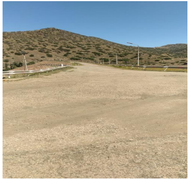
Figure II.10 : Une digue Ou barrage principal (2024)
