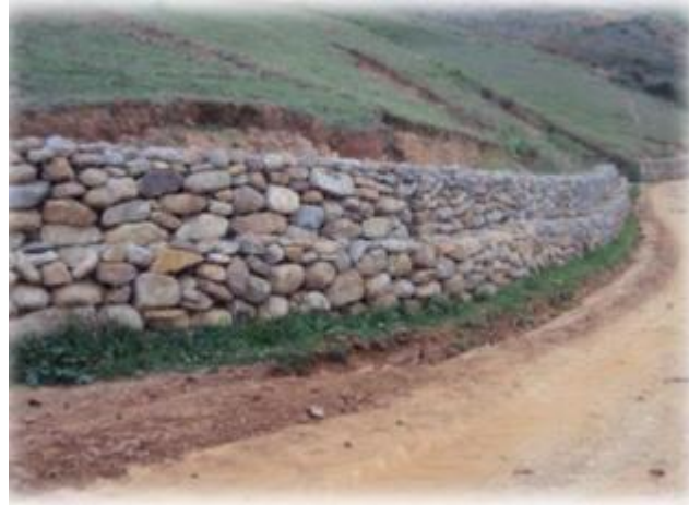
Figure IV.7 : gabionnage des sols.
