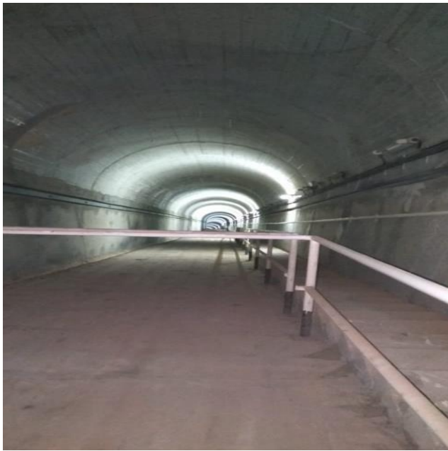
Figure II.9 : Galerie d'injection du barrage
