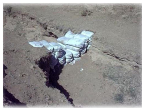
Figure IV.8 : (Seuil en gabions, Seuil en grillage métallique, Seuil en pneus usés, Seuil en sacs de plastique)
