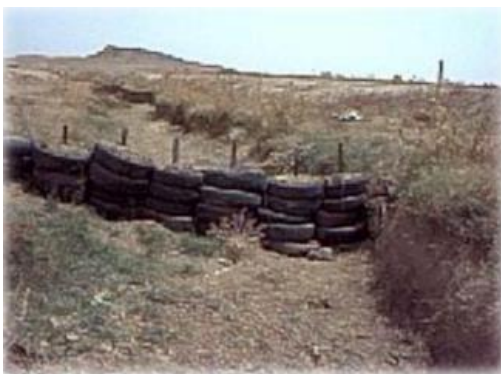
Figure IV.8 : (Seuil en gabions, Seuil en grillage métallique, Seuil en pneus usés, Seuil en sacs de plastique)
