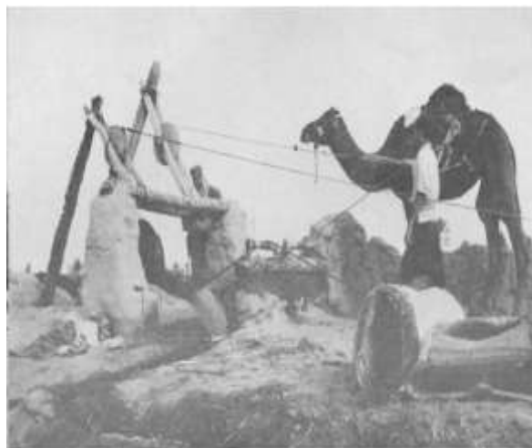
Fig.4 Photo d'un puisage par traction animal dans les oasis de Tafilalet (Ben Brahim, 2003)
