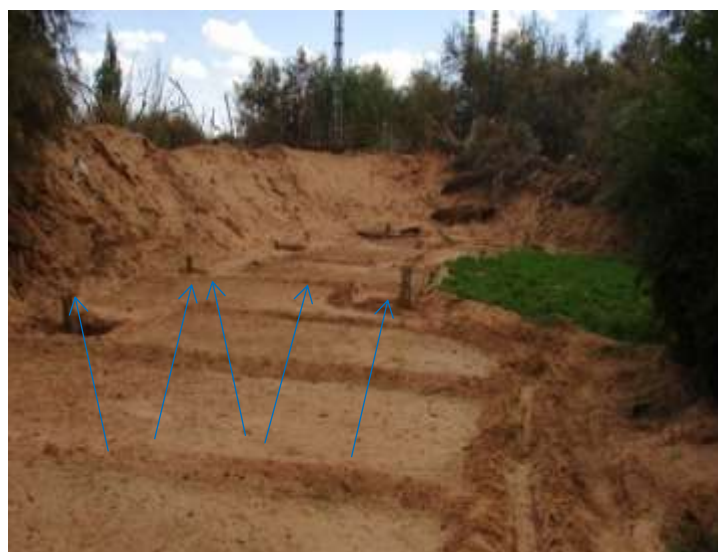
Fig.75 Retenue des eaux de crue dans le jardin
