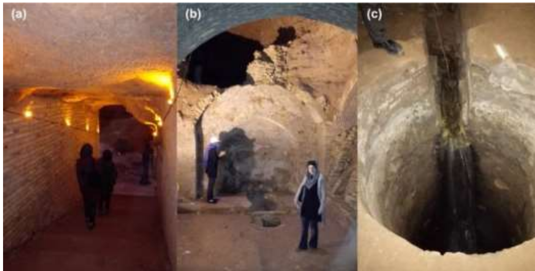
Fig.30 Moulin à eau du qanât de Zarch à Yazd, en Iran: (a) La descente vers le moulin ; (b) La partie centrale du moulin où se trouve le rotor en bois, les meules et le bac à recevoir la farine ; (c) L'eau du qanât descendant en chute libre pour pousser les pales du rotor (Megdiche, 2015)
