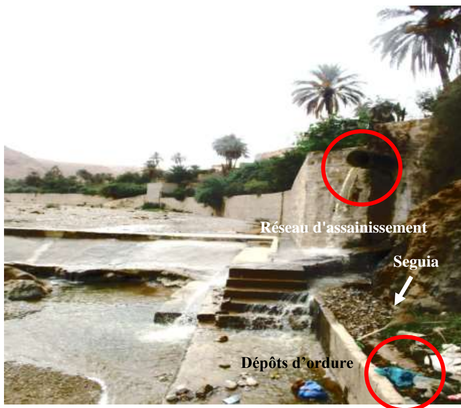
Fig.39 La présence d'un réseau d'assainissement au-dessus la seguia
