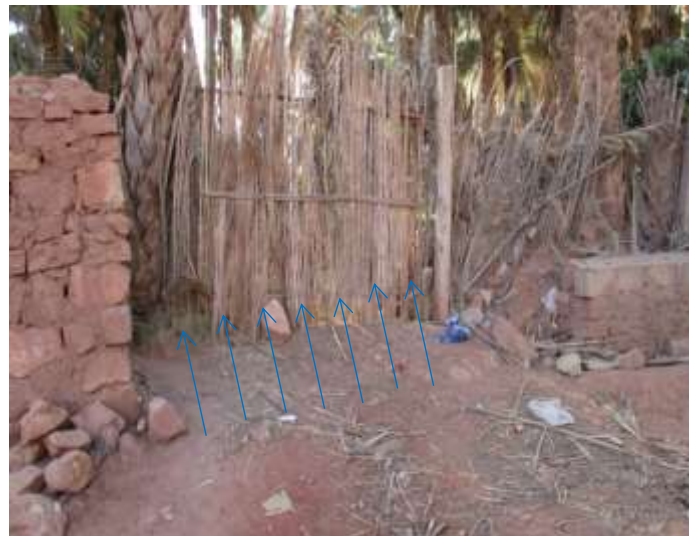
Fig.74 La crue se déverse vers la retenue
