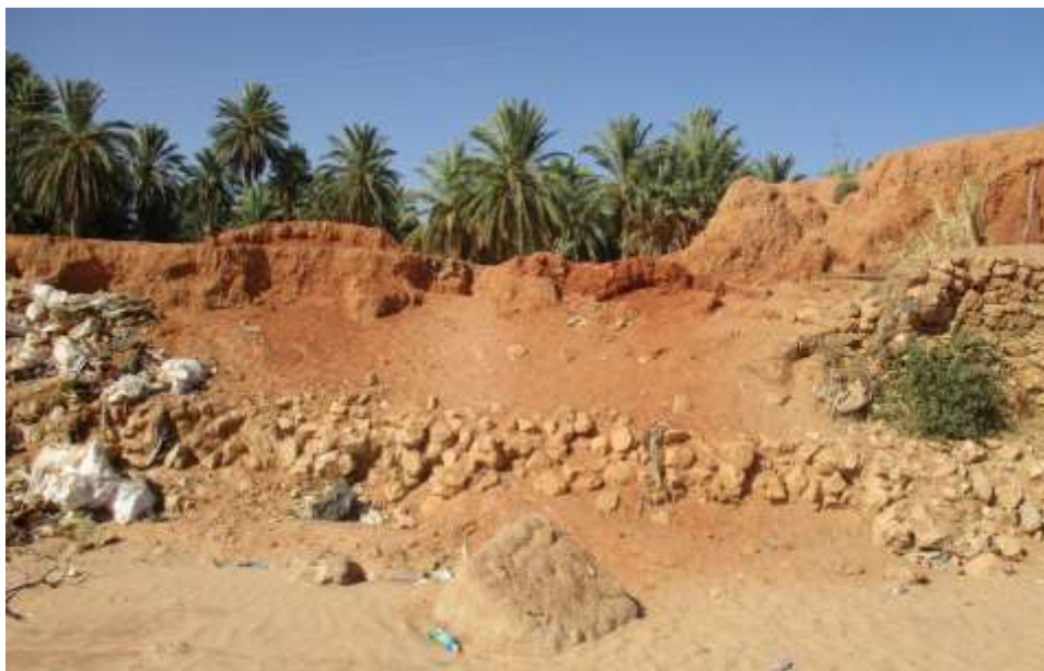
Fig.68 Une vue de la digue
