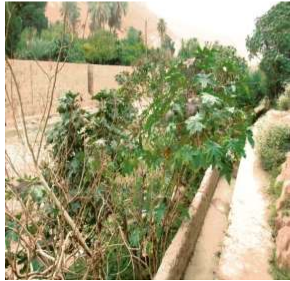
Fig.44 Une partie de la seguia Khachbat colmatée par la boue
