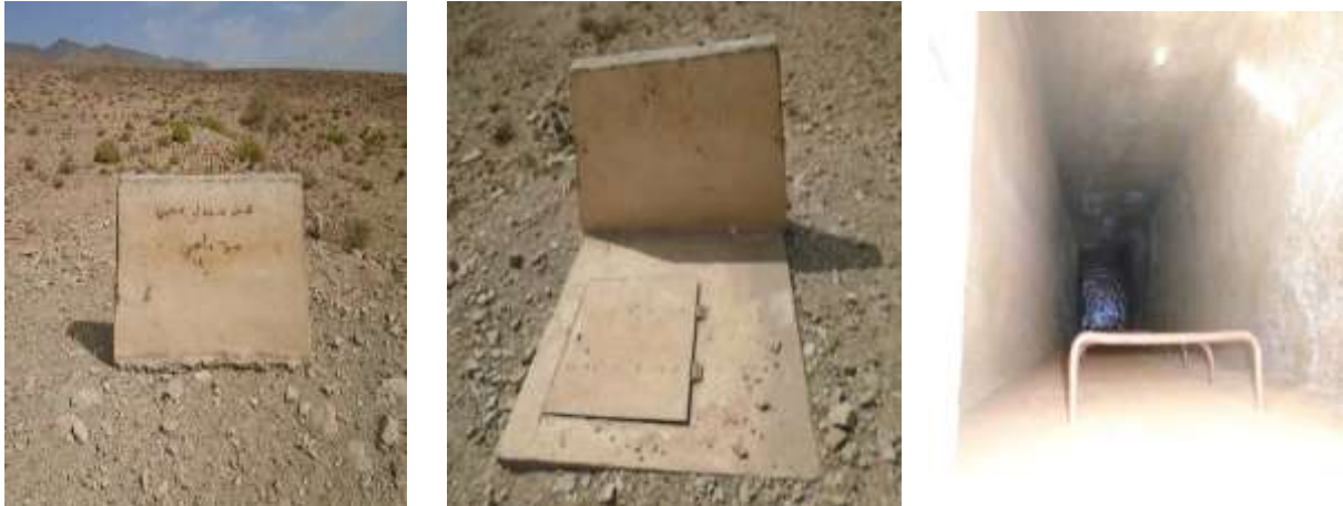
Fig.79 Puits d'aération de Foggara d'Aïn Madhi
