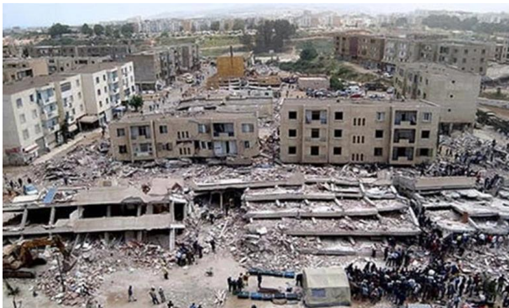
Figure I.1 : Séisme du 21 Mai 2003, Wilaya de Boumerdes. [1]
