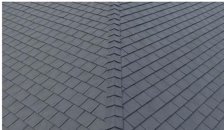
Figure 2.13 Toit pneu recyclé ( https://www.toiturepro.com/ )
