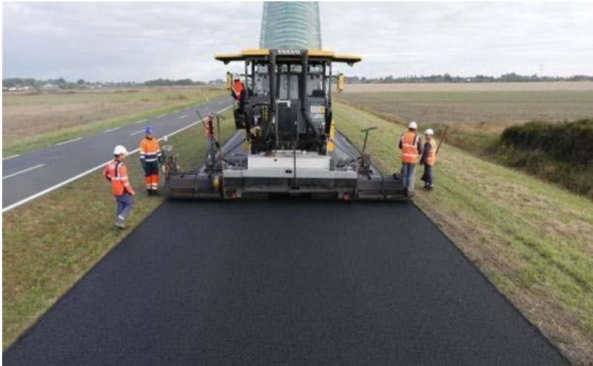
Figure 3.33 Une route à base de caoutchouc ( https://www.environnement-magazine.fr/ )
