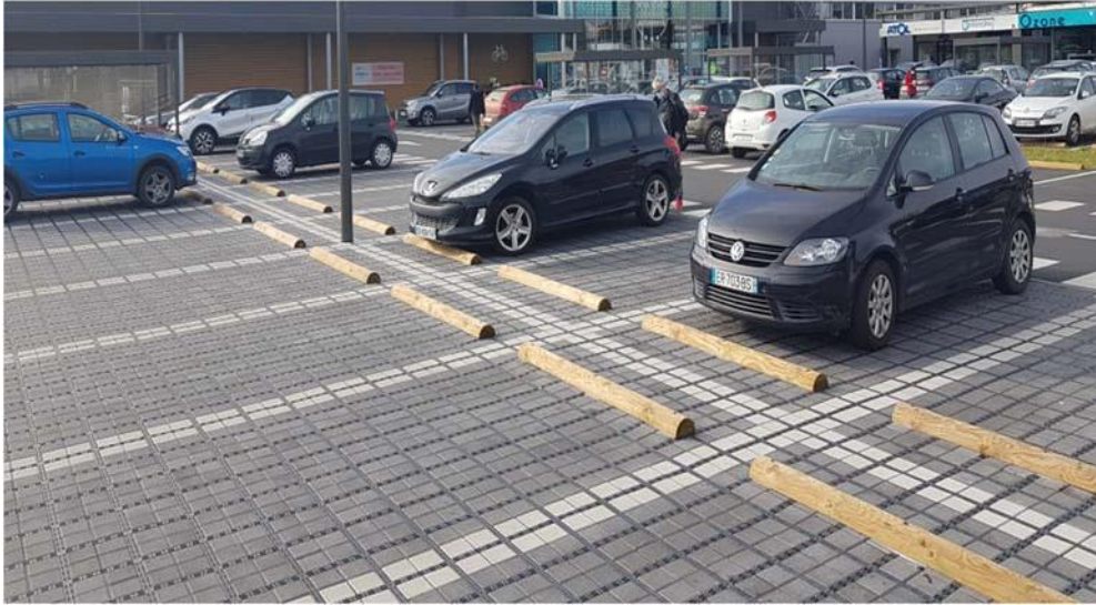
Figure 3.29 Revêtement de sol de parkings à base de caoutchouc
