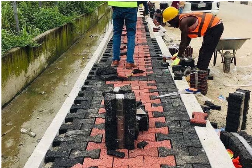
Figure 3.27 Un trottoir à base de caoutchouc ( https://www.neozone.org/ )
