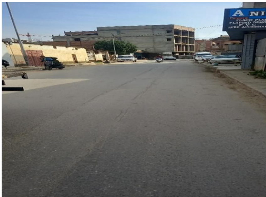
Figure 3.32 Exemple d'une route à base de bitume à la ville de chlef
