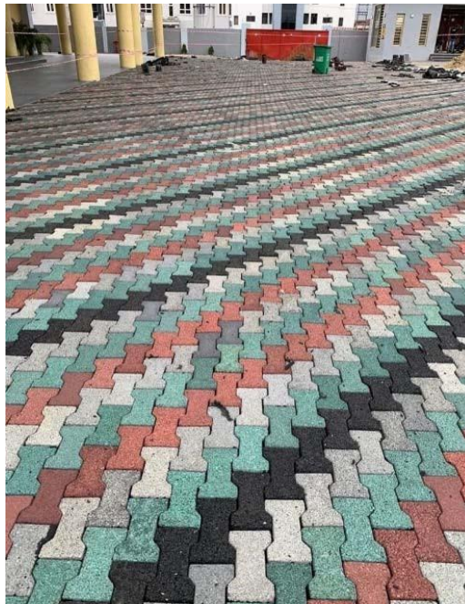
Figure 1.19 Le pavage d'un trottoir ( https://www.neozone.org/ )
