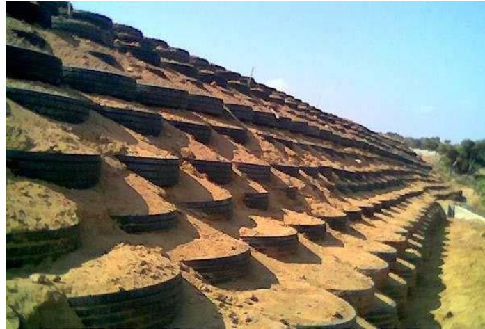
Figure 2.23 Chantier expérimental Pneu-sol à Bou-Smail (H.Trouzine, and all, Grenoble 2005)
