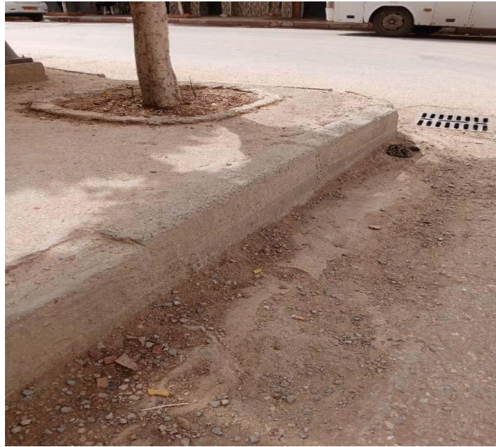
Figure 3.30 Une bordure de trottoir à Chlef
