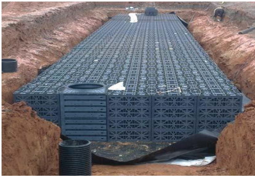
Figure 2.21 Bassin d'infiltration ( https://batiactu.com/ )
