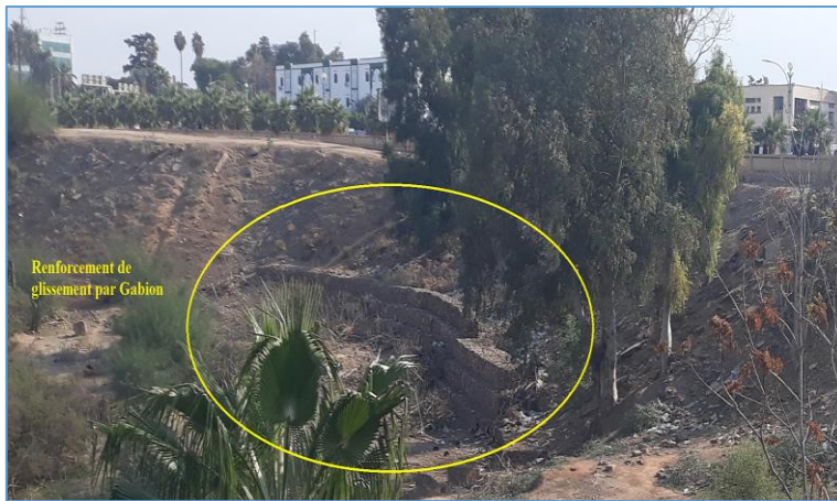
(a) Renforcement de glissement
