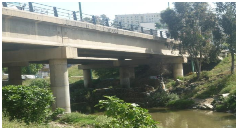
Figure III.13 : Vue de pont M'KHADRIA. (Source de l'image : Kibboua, 2012 )
