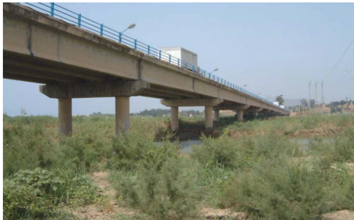
Figure III.15 : Vue du pont SEBAOU. (Source de l'image : Kibboua, 2012 )
