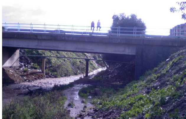
Figure III.9 : Vue de pont MEURAD. (Source de l'image : DTP, Tipaza)
