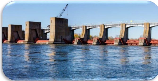
Figure I.3 : Exemple d'un pont non courant (Source : https://www.ouvrages-arts.com )
