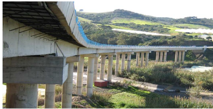
Figure III.7 : Vue de pont de HARBIL. (Source de l'image : DTP, Tipaza)
