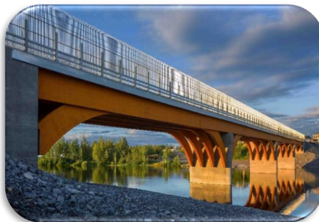
Figure I.1 : Exemple d'un ouvrage d'art (Source : https://www.stantec.com/bridges )
