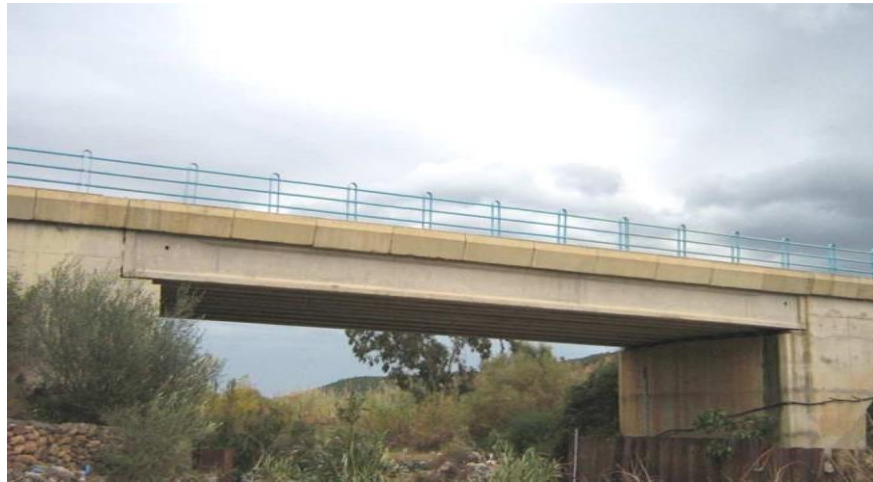
Figure III.11 : Vue de pont de BOUKADIR (Source de l'image : DTP, Tipaza )
