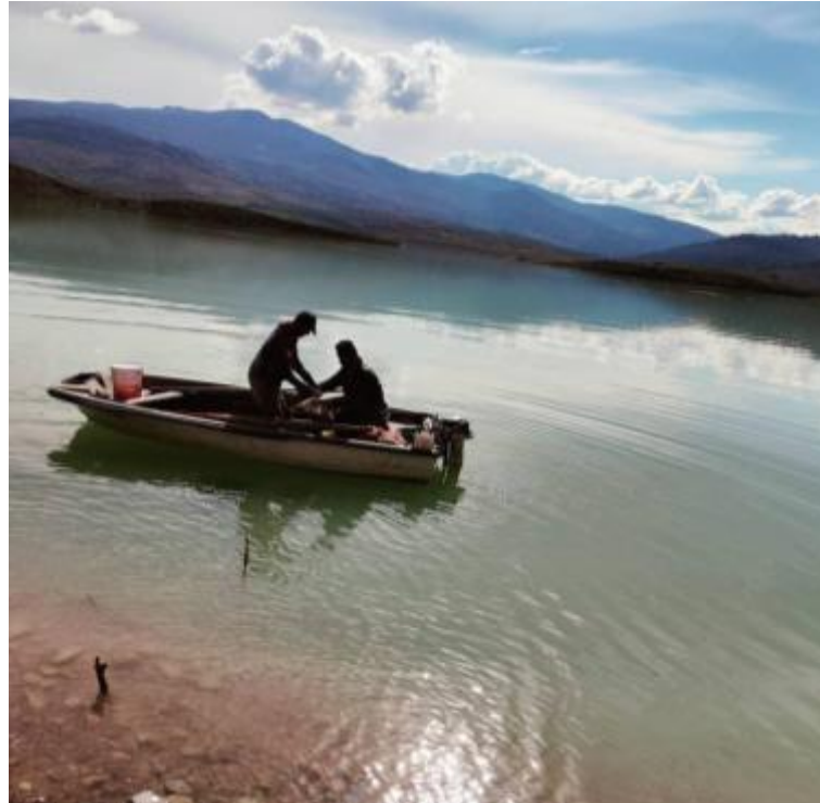
Figure 2. 2 : Extraction de la vase du barrage.
