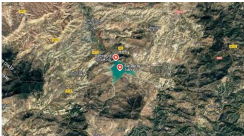
Figure 2. 1 : Barrage de Sidi Yacoub.
