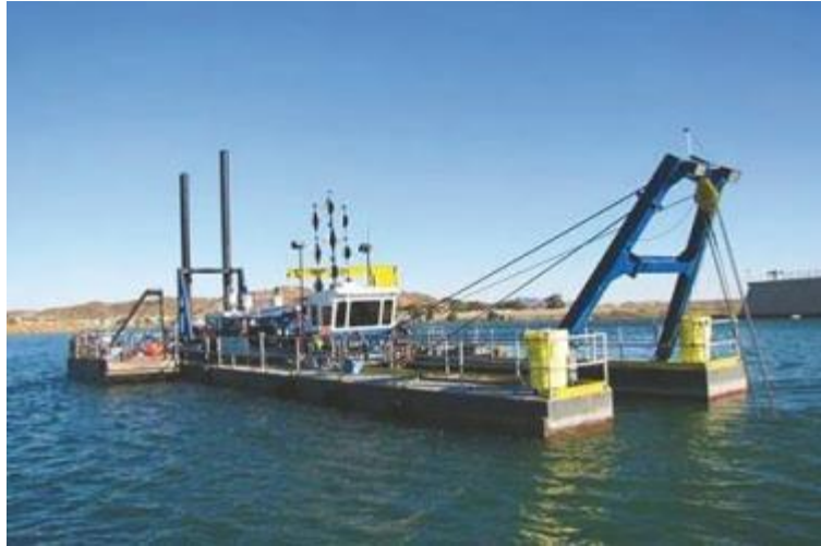
Figure 1. 4. Opération de dragage.
