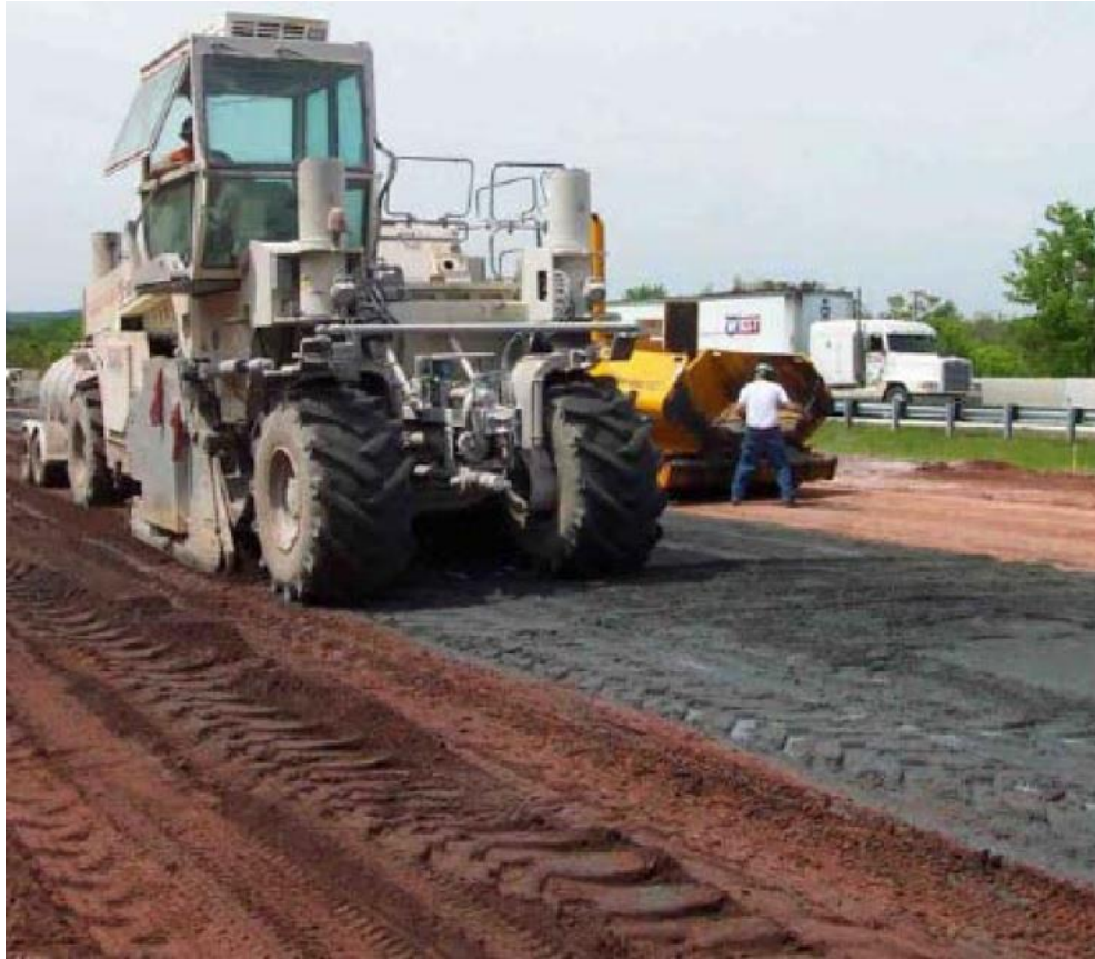
Figure 1.18 : Stabilisation des couches de base en remblai routier par cendres volantes (Beeghly, 2003)
