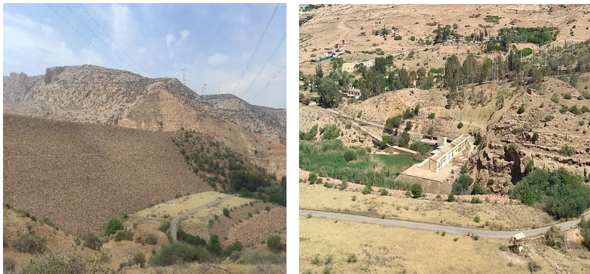
Photos.II.I.2. Vue générale de la digue du barrage Algérien de Gargar.
