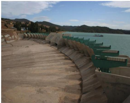
Fig. 1.12 — Surélévation du barrage Ghrib par des hausses fusibles (Remini, 2018).
