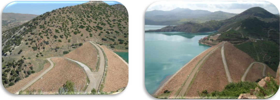
Fig. 3.5 — Digue en terre du barrage de Sidi Yacoub, (ANBT,2019).
