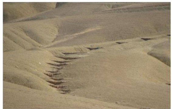
Fig. 1.9 — Une série de seuils réalisée sur une ravine dans un bassin versant ( Remini, 2014 ).
