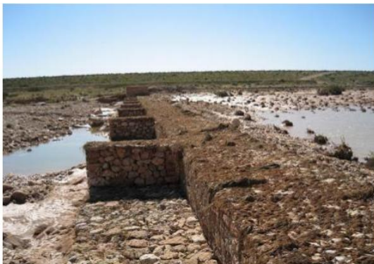
Fig. 1.8 — Gabionnage contre l'érosion.
