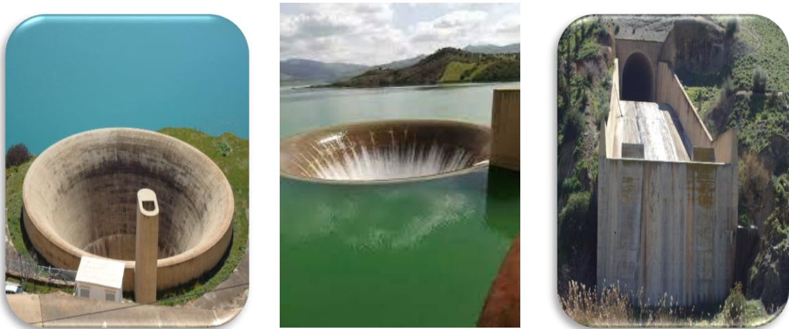
Fig. 3.6 — Evacuateur de crue, (ANBT,2019).
