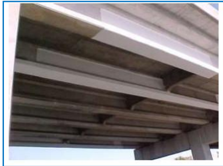
Figure I.3 : Poutres réparées à l'aide d'un enrobage continu en CFRP (Photo : Toenjes, 2005) [18].
