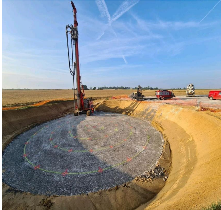
Fig. I.6. Vibroflotation ou vibrocompaction ( https://www.menardfrance.fr )
