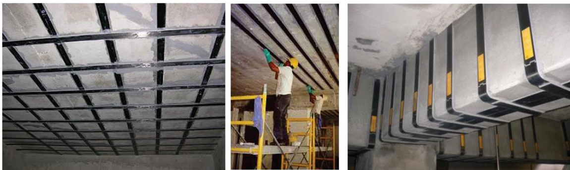
Figure 1.6: Renforcement des structures en béton par CFRP [37].
