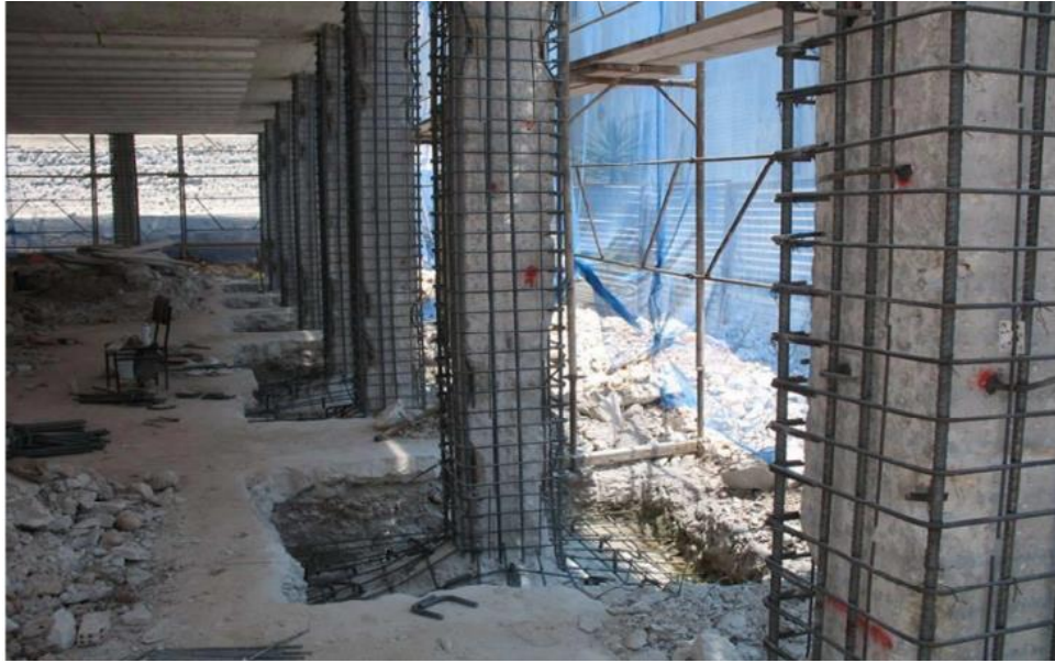
Figure 1.4: Renforcement par chemisage en béton.
