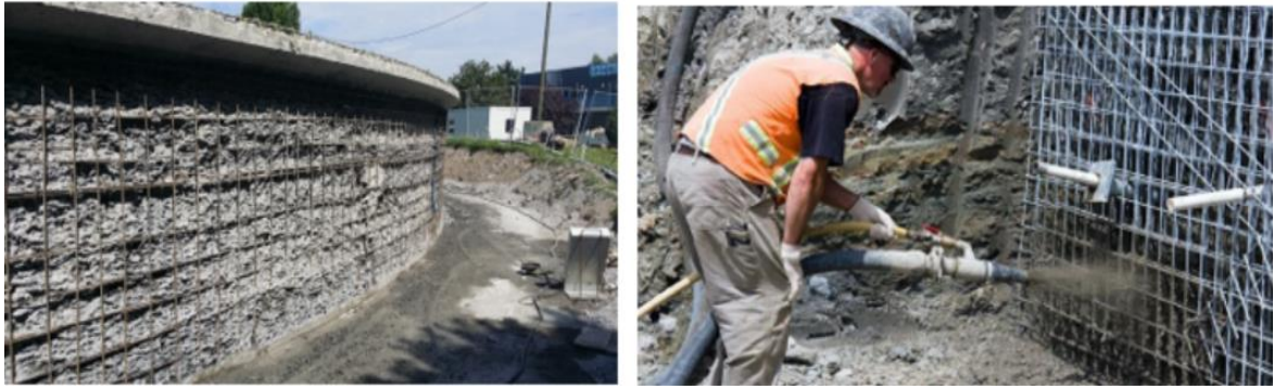
Figure 1.5: Renforcement par béton projeté [32].
