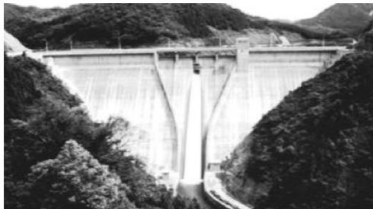
Figure 1. 6. Barrage de Shimajigawa au Japon[26].
