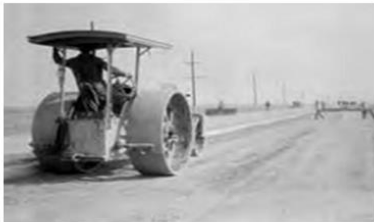
Figure 1. 4. Une technique de pavage considérée comme BCR en Suède en 1930 [24].
