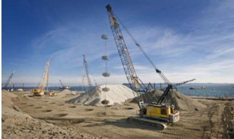
Figure. 1.9: Chantier d'un compactage dynamique profond
