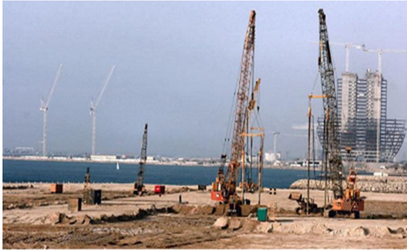
Figure.1.10 : Procédé du vibrocompactage
