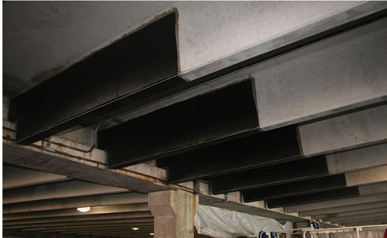
Fig. 1.5 — Renforcement par composites PRF collés extérieurement (EBR).
