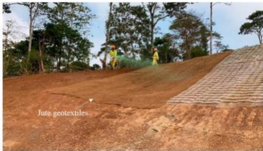
Figure 2.18: Utilisation de géotextiles de jute pour le contrôle de l'érosion et la stabilisation des pentes (projet pratique réalisé au Vietnam, 2022-2023, photo fournie par FUCON).
