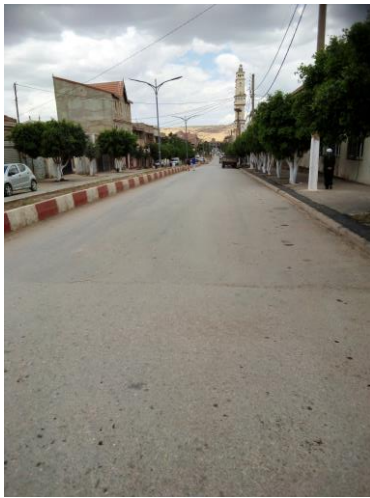
Figure 20: Voirie bon état
