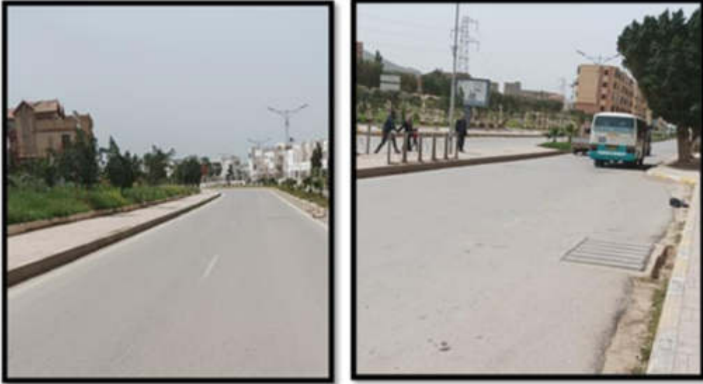
صورة 22 توضح ملتقطات للطريق الاجتيابي
