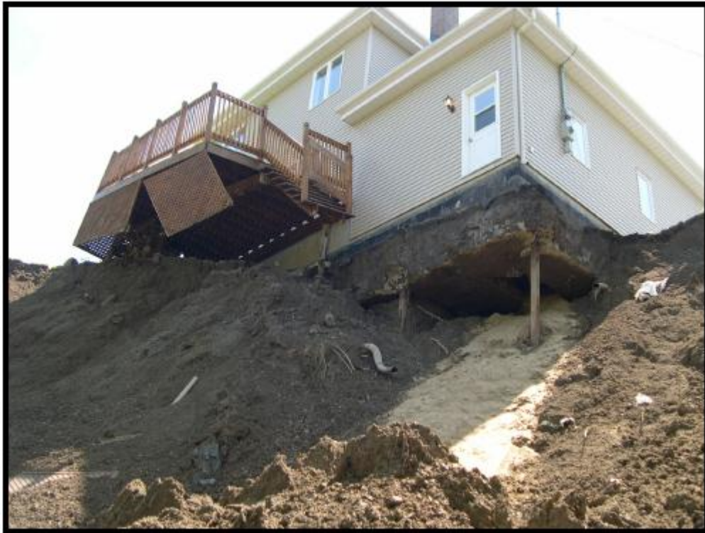
Figure .1.3. Glissement rotationnel dans des sols argileux [rivière Delisle,2005]
